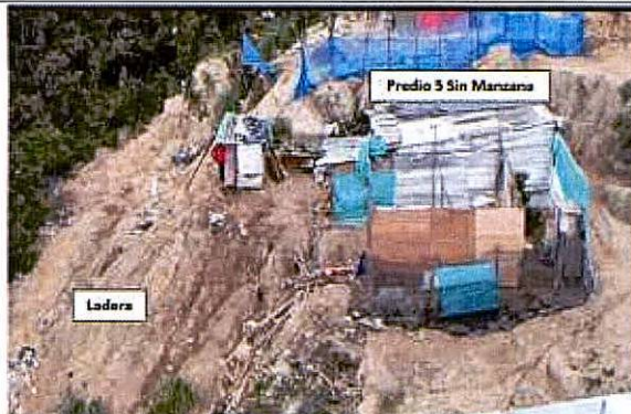
Foto 12. Vista predio zona de invasión junto a una ladera
