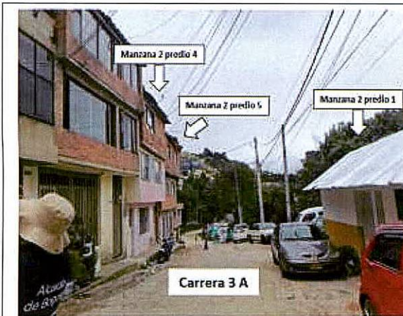
Foto 4. Carrera 3A, presenta algunos daños el pavimento
