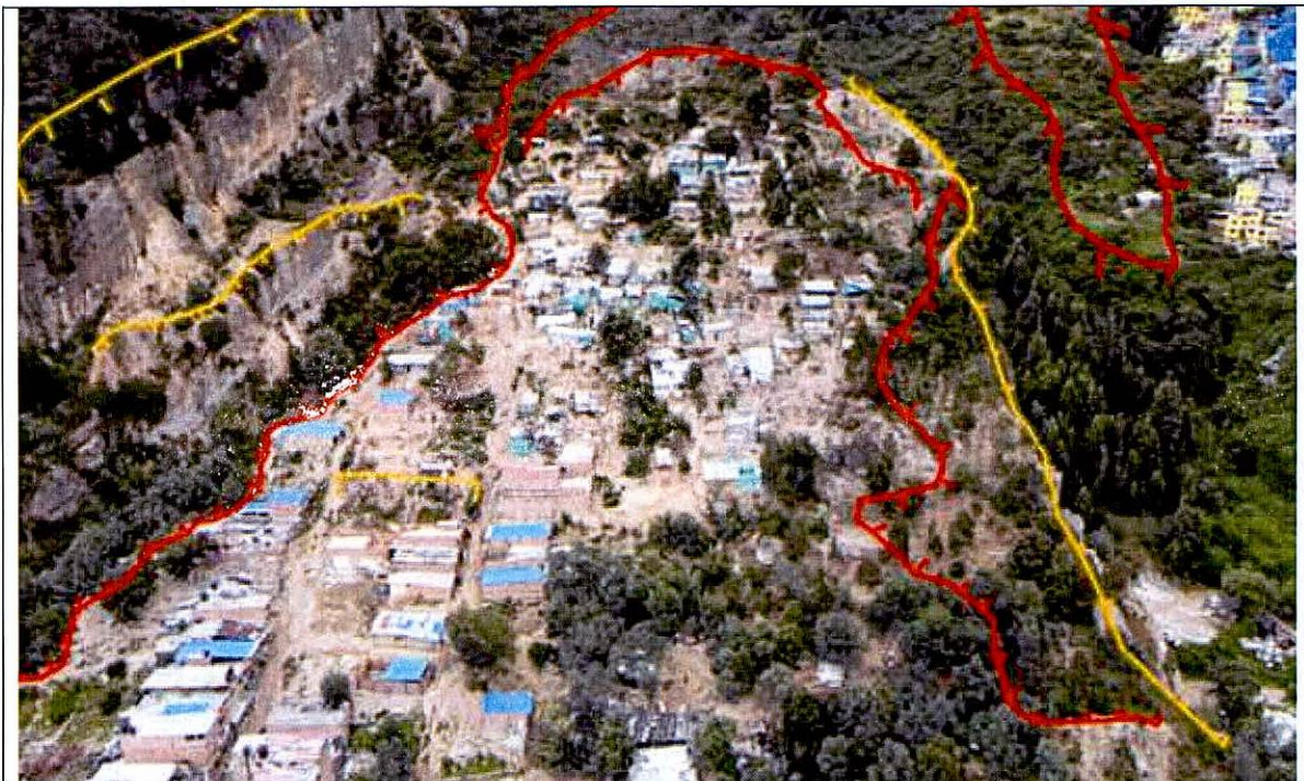
Foto 28. Zona de deslizamiento principal donde se implantaron las viviendas y manzanas reconocidas por cartografía oficial
