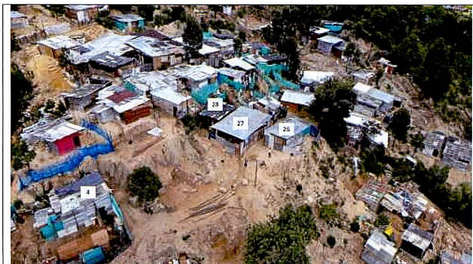
Foto 37. Cortes para implantación de viviendas y paso de aguas residuales
