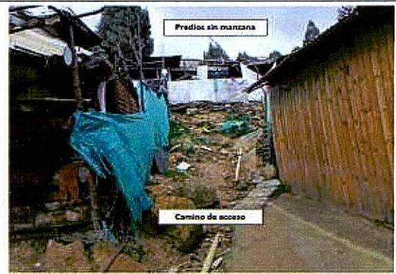
Foto 11. Vista predios sin sistema estructural zona invasión
