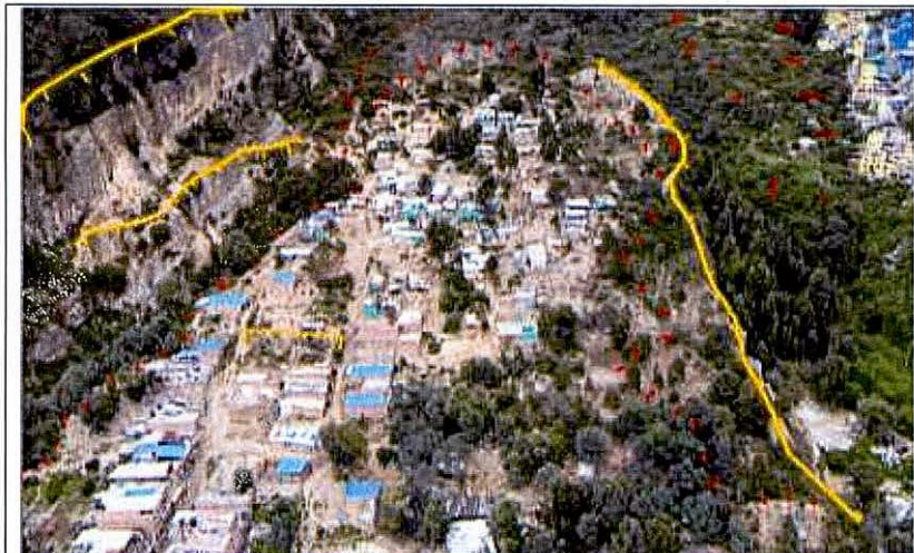
Foto 31. Evolución de dos procesos iniciados en zona de brecha de falla, y acentuado por infiltraciones y recargas hídricas. Zonas de escarpes antiguos.
