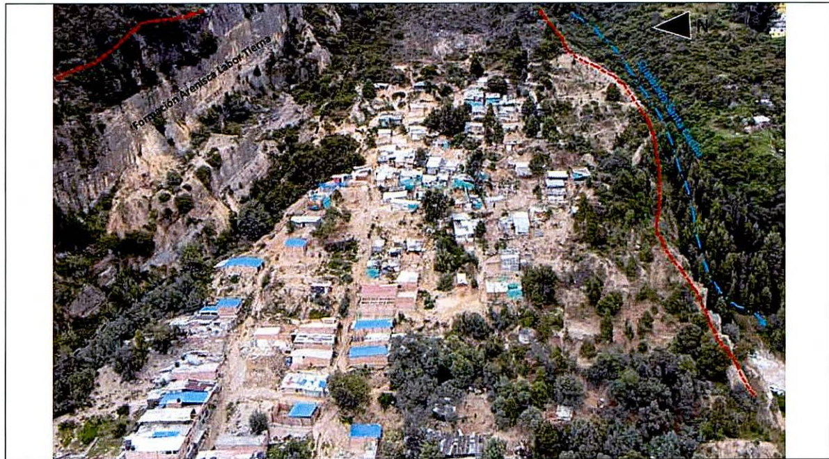
Foto 17. Barrio Santa Cecilia - Komauco. Al norte se observa el escarpe (color rojo) producto de antiguas actividades extractivas que exponen el macizo rocoso el cual buza a favor de la pendiente. Al sur del barrio se observa la incisión del terreno por la presencia de la quebrada Santa Cecilia.
