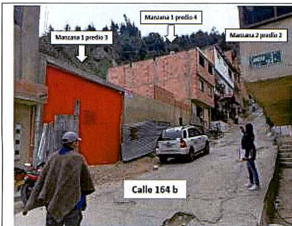
Foto 2. Calle 164 b, con daños como grietas y baches
