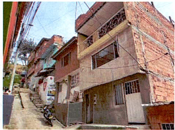
Fotografía 6. Vistas de las seis viviendas V5, V6, V7, V8, V9 y V10, actualmente demolidas (Fotografía tomada del DI-15916)
