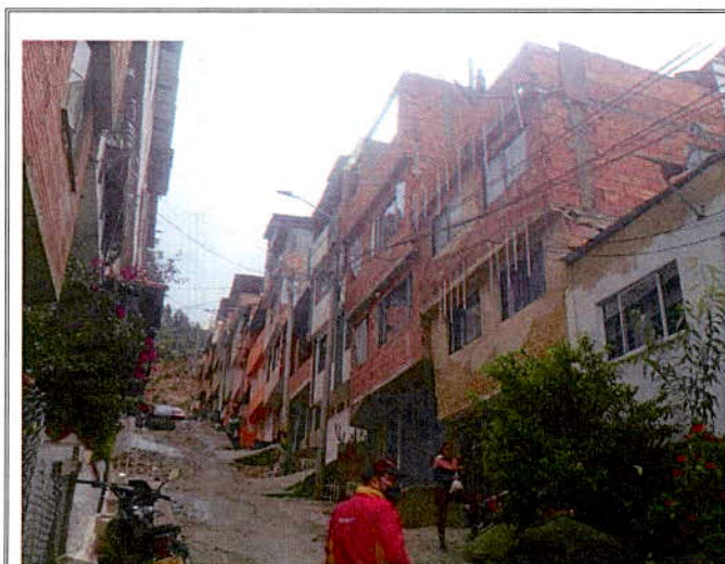
Fotografía 1. Sector localizado en la parte baja de la ladera donde se ubican edificaciones de uno a cinco niveles, por la Calle 163 B.
