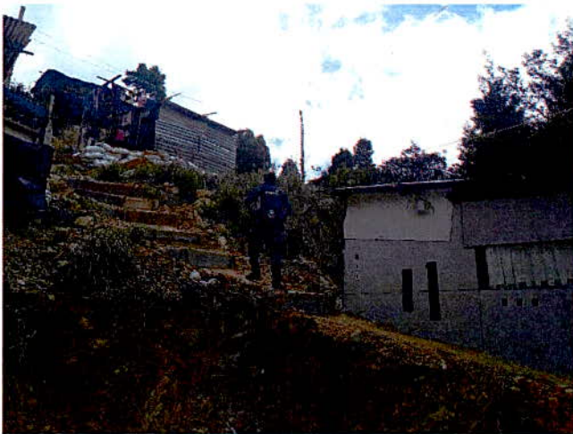
Fotografía 17. Vista de la zona alta de la ladera en el polígono inspeccionado en donde se observan múltiples ocupaciones, la construcción de nuevas ocupaciones y la adecuación del terreno para futuras ocupaciones.
