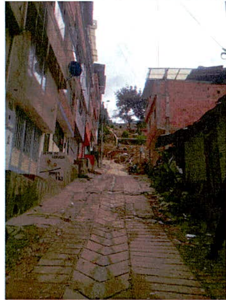
Fotografía 4. Sector localizado en la parte baja de la ladera donde se ubican edificaciones de uno a cinco niveles, por la Calle 163 A.
