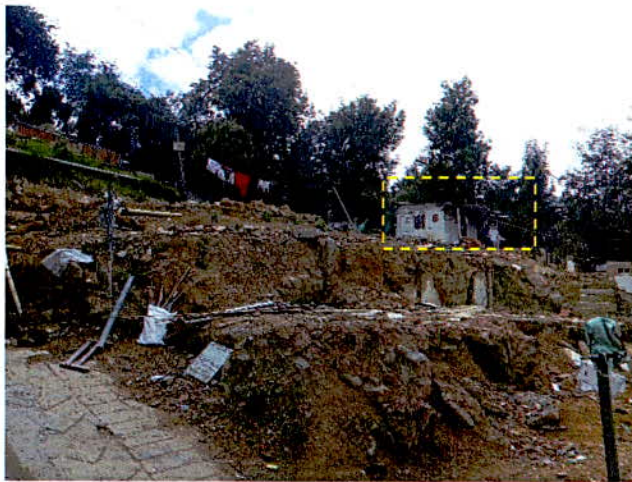
Fotografía 5. Vista de los seis predios demolidos en donde se ubicaban las viviendas V5, V6, V7, V8, V9 y V10. Se observan las dos unidades habitacionales identificadas en el DI-16210.
