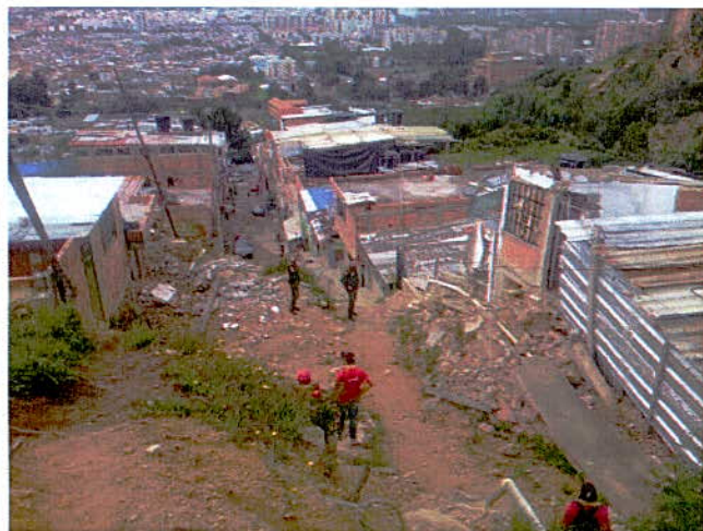
Fotografía 11. Vista de la zona media de la ladera en el polígono inspeccionado. El acceso a las viviendas del sector se realiza por senderos peatonales en suelo natural.
