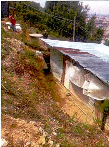
Fotografía 21. Vista de la zona alta de la ladera en el polígono inspeccionado en donde se observan múltiples ocupaciones, la construcción de nuevas ocupaciones y la adecuación del terreno para futuras ocupaciones.
