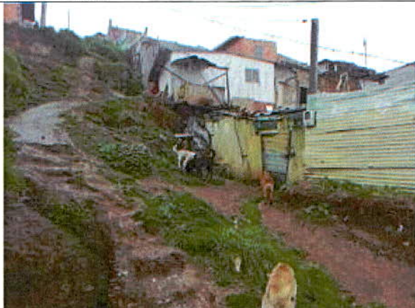
Fotografía 7. Emplazamiento de la vivienda sobre taludes de corte y adecuación en el terreno.
