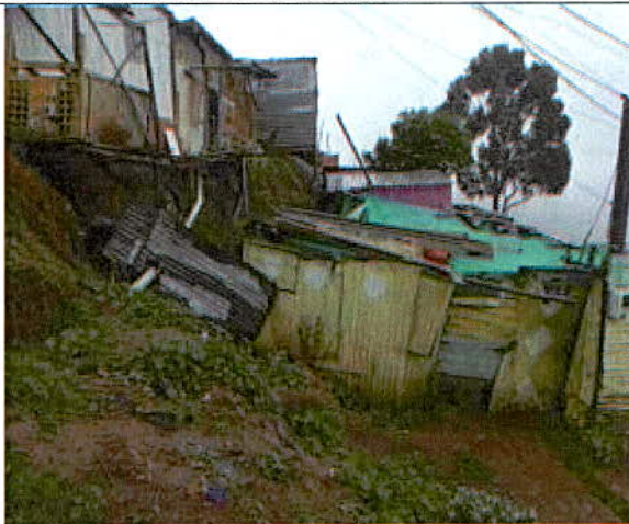
Fotografía 6. Configuración escalonada para el emplazamiento de las viviendas.
