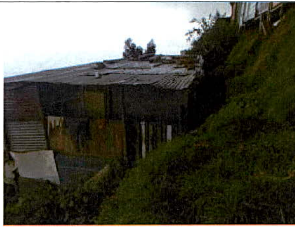
Fotografía 4. Viviendas construidas sobre taludes de corte sin medidas de contención.
