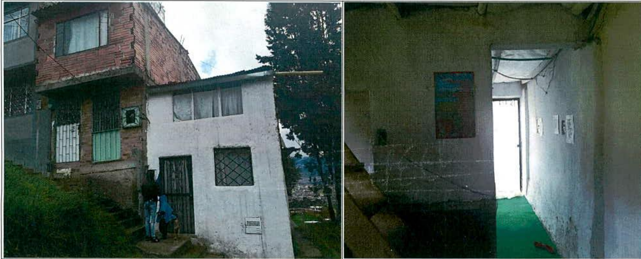
Fotografías 1 y 2. Predio de la Calle 70B Bis Sur No 40B-04 CHIP AAA0028XBNN, barrio Arborizadora Alta de la Localidad de Ciudad Bolívar.
