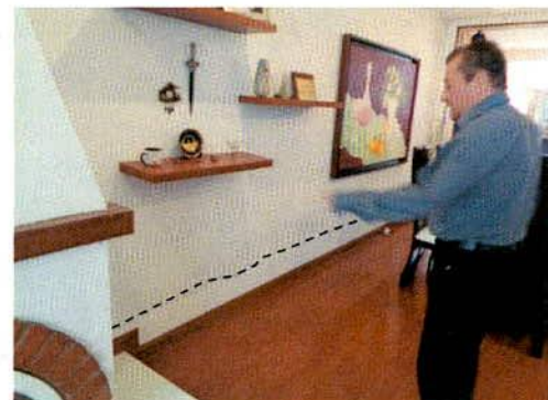
Fotografía 3 y 4. Fisura en el muro del costado occidental del Interior 1 del predio de la Calle 142 No 11-34
