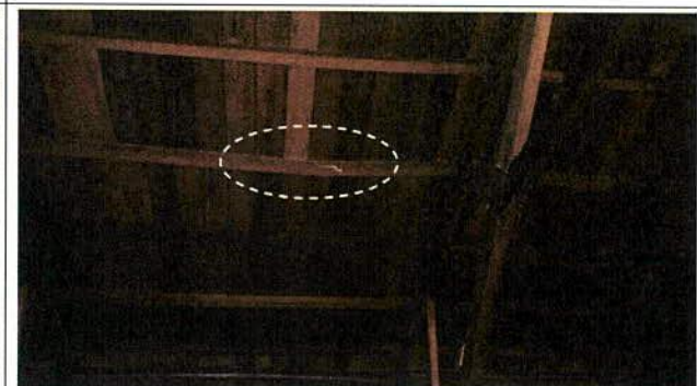
Fotos 11 y 12. Vista de los daños que presenta el entramado en madera que soporta la cubierta.
