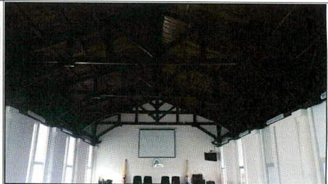
Fotos 10. Vista de la cubierta de la edificación donde funciona la JAL de Barrios Unidos.
