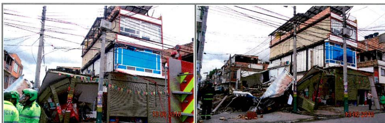
Foto No. 1 y 2. Vista frontal de las edificaciones emplazadas en los predios de la Calle 22 Sur No. 52 – 16 / 20, Sector Catastral San Eusebio de la Localidad de Puente Aranda
