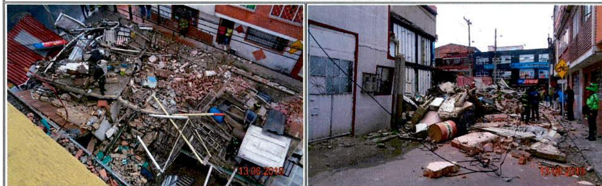
Foto No. 3 y 4. Colapso de la estructura emplazada en el predio de la Calle 22 Sur No. 52 - 16
