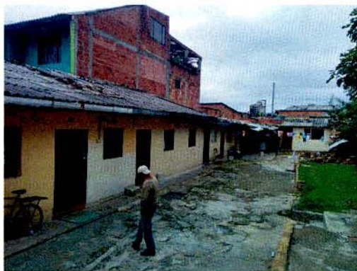
Foto 2. Vista interior de la vivienda de la Calle 2 A # 5 A - 24
