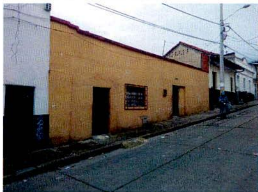
Foto 1. Vista exterior de la vivienda de la Calle 2 A # 5 A - 24.
