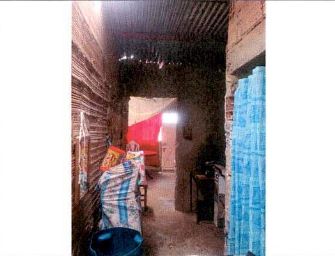
Fotografía 5. Interior de la vivienda ubicada en el predio de la Calle 87 B Sur No. 7 C - 17 Este.
