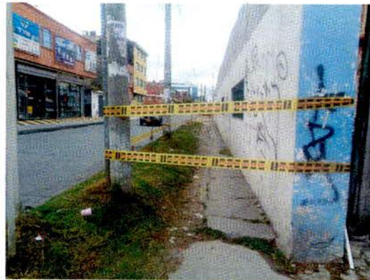
Fotografía 3. Restricción de uso del sendero peatonal de la Carrera 21 con Calle 162.
