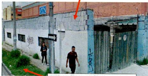
Sendero peatonal afectado
