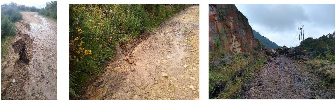
Figura 49. Evidencia de la inexistencia de obras hidráulicas de captación en las vías de acceso.
