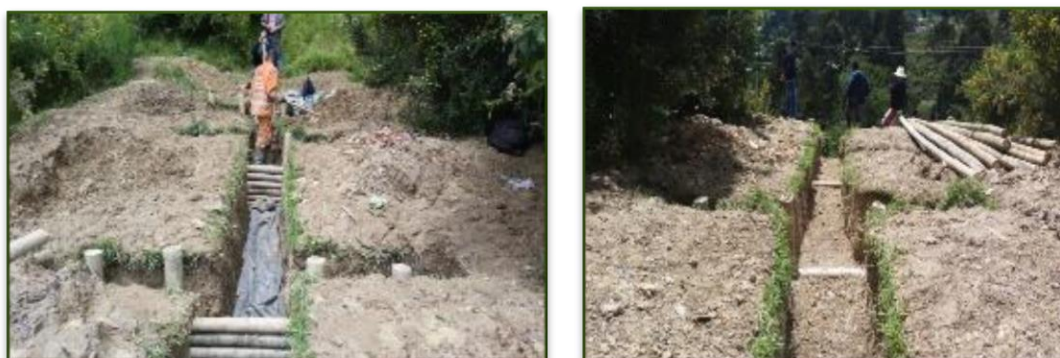
Ilustración 2-180 Construcción de un filtro vivo
