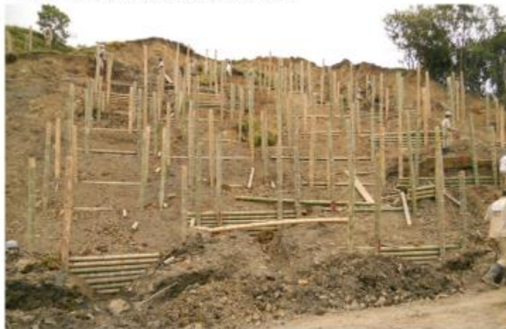
Filtros vivos construidos, sitio El Carmen.
