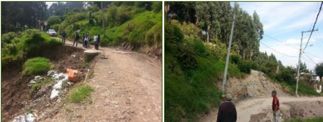
Ilustración 2-100 Perdida de la bancada - Escarpe superior
