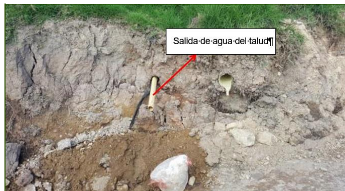
Ilustración 2-11 Salida de agua por dren horizontal
