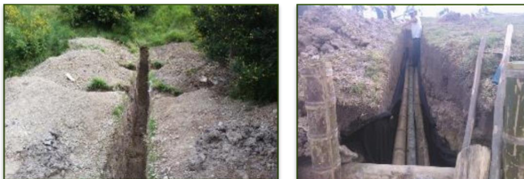
Ilustración 2-179 Construcción de canal paralelo
