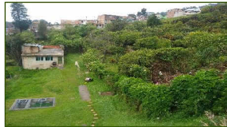
Ilustración 2-50 Proceso de sucesión vegetal sobre el área intervenida con bioingeniería
