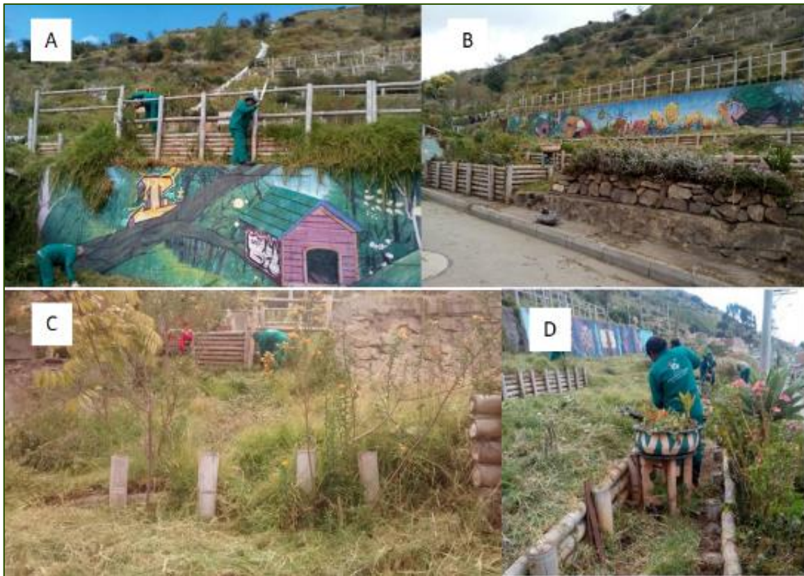
Ilustración 2-59 Proceso del mantenimiento a) jardineras en proceso de mantenimiento b) jardineras mantenidas c) mantenimiento de trinchos disipadores d) mantenimiento de terrazas invertidas.
