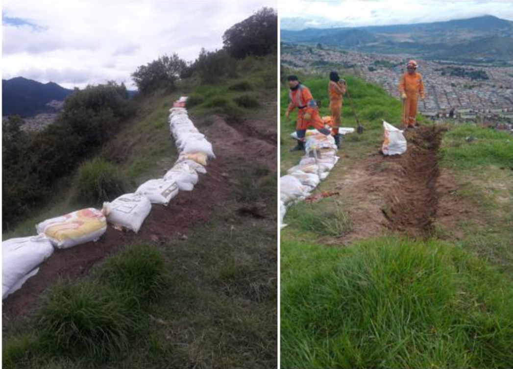
Ilustración 3-140 Obra de emergencia que tiene estable el talud oriental
