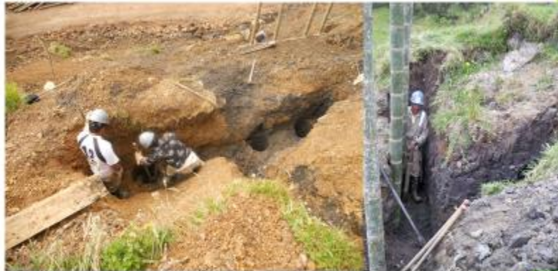
Trinchos escalonados para filtros vivos en construcción, sitio El Carmen.
