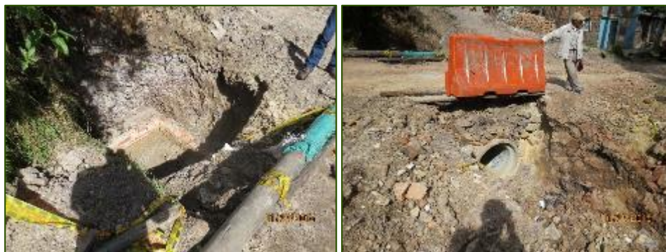
Ilustración 2-136 Caja colectora - Tubo de 32”
