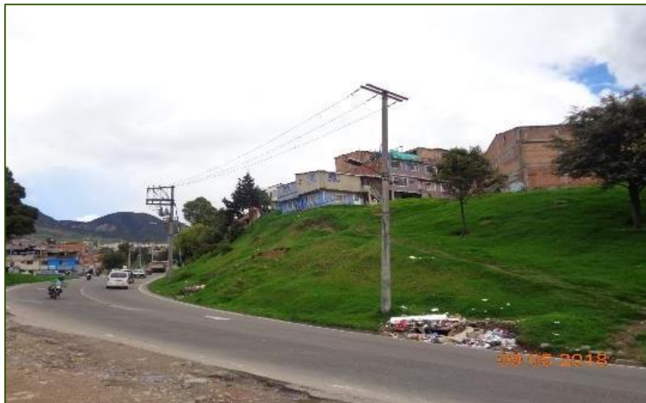
Ilustración 3-54 Vista panorámica del lado izquierdo del talud
