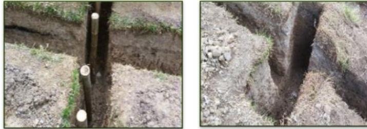
Ilustración 2-177 Construcción de trincho disipadores transversales escalonados para Filtros Vivos 29
