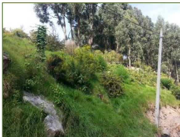
Ilustración 2-98 Zona de alto agrietamiento.
