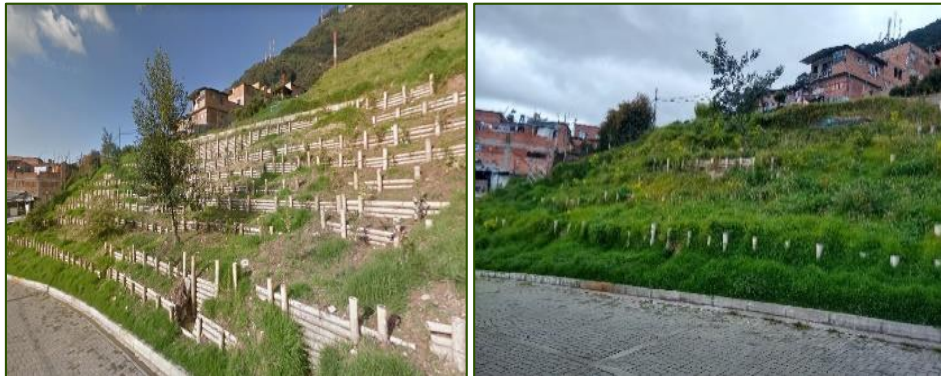
Ilustración 2-23 Obra de Bioingeniería San Martin Porres recién contruida y su estado actual.
