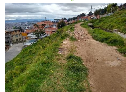
Ilustración 2-28 Gusanillo para control y direccionamiento del agua de escorrentia
