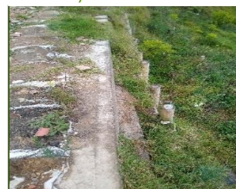
Ilustración 2-27 Obra de bioingeniería para avitar deterioro del talud y la socabacion de muro
