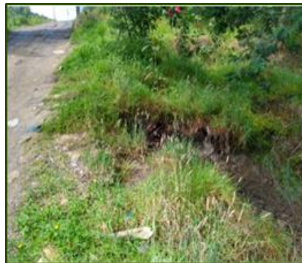
Ilustración 3-97 Vista lateral a la entrada de agua desde la vía
