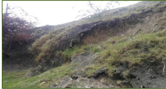
Ilustración 3-118 Extremo norte del talud
