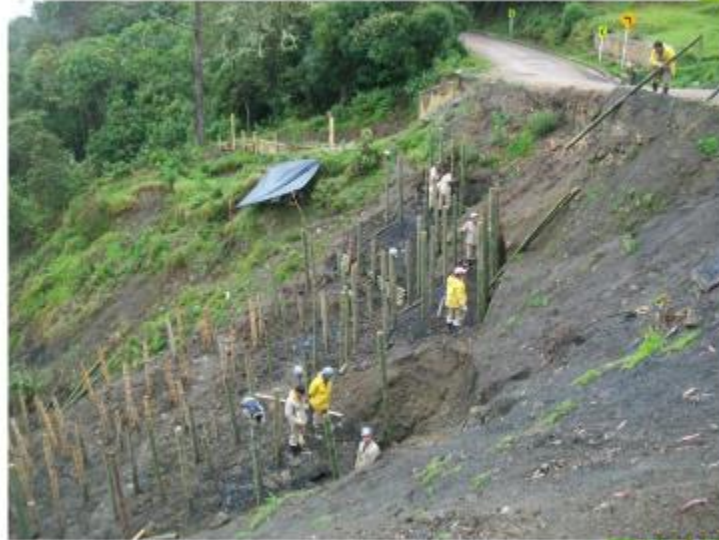
Filtro vivo en construcción, talud inferior, sitio El Carmen.
