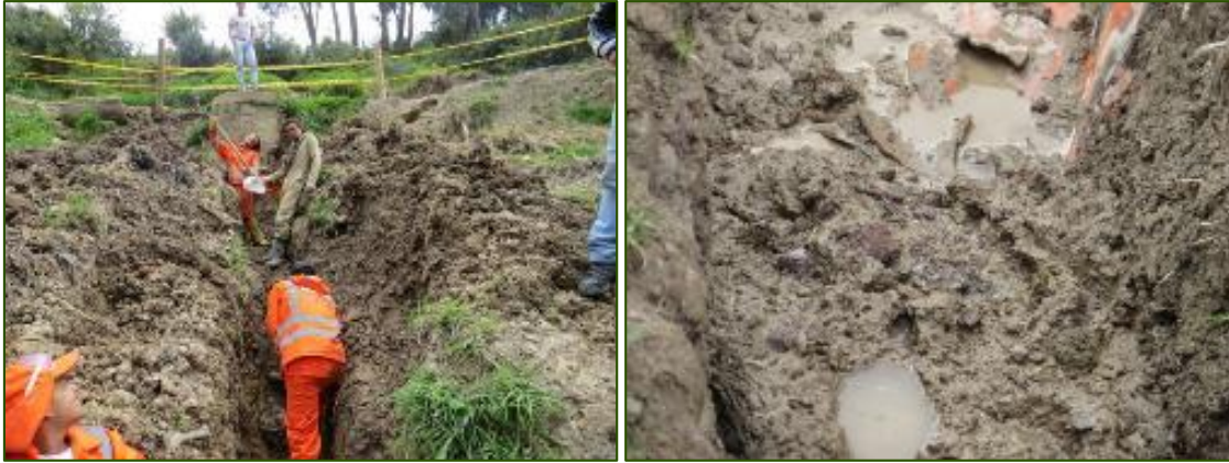
Ilustración 2-113 Construcción terrazas - Terrazas Compactadas
