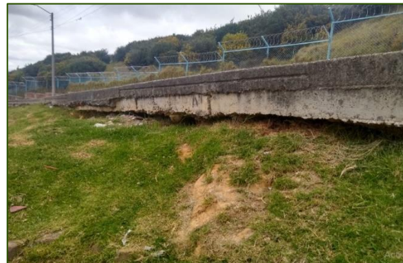
Ilustración 3-114 Proceso erosivo, afectando la estructura del pavimento
