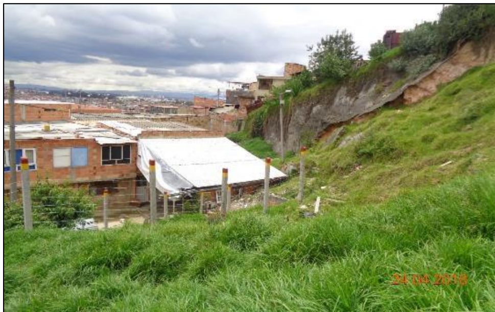
Ilustración 3-13 Vista general de la área afectada, predios reasentados y talud expuesto. Vista superior
