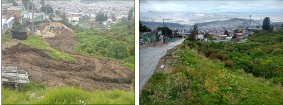
Ilustración 2-45 Obra de Bioingeniería San Martín Porres recién contruida y su estado actual.
