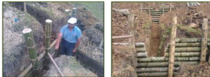
Ilustración 2-178 Construcción de trincho disipadores transversales escalonados para Filtros Vivo 33
