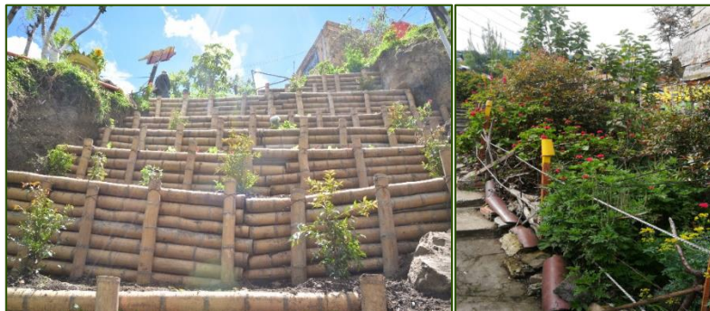
Ilustración 2-160 Obra de Bioingeniería, Vista inferior y superior
