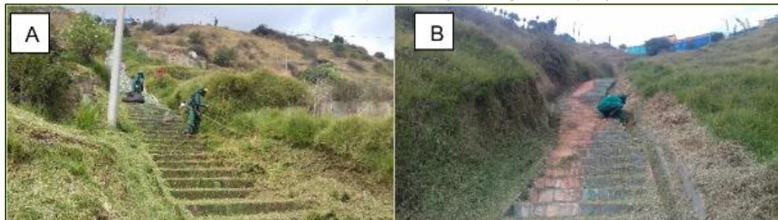
Ilustración 2-72 Mantenimiento de senderos. A) Proceso de poda con guadaña. B) limpieza de canales.
