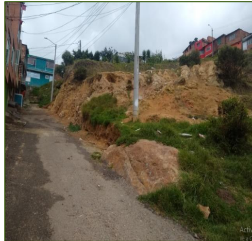
Ilustración 3-128 Talud excavado en la Cra 17L al sur del proceso
