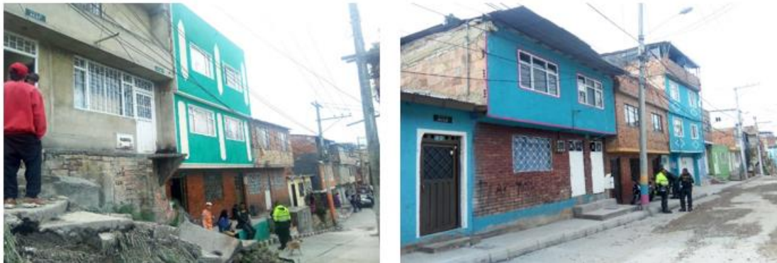
Ilustración 3-136 Viviendas localizadas en la parte baja de la ladera.
