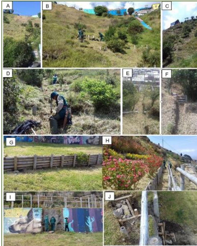
Ilustración 2-71 Actividades de mantenimiento de bioingeniería. A) filtro 0 y 1 sin mantenimiento. B) actividades de mantenimiento del filtro 0 y 1 c) filtro después del mantenimiento. D) limpieza de los trinchos. E) filtro 2 después del mantenimiento. F) trinchos
