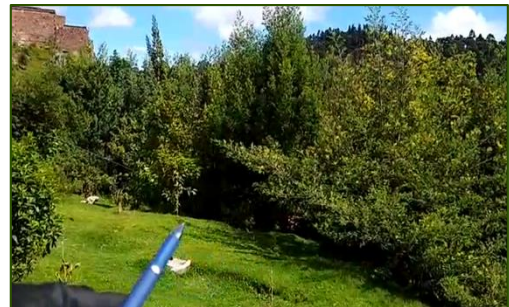
Ilustración 3-92 Alcantarillado parte alta mal compactado parcialmente
