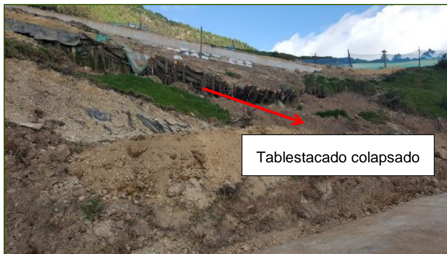
Ilustración 2-9 Tablestacado colapsado
