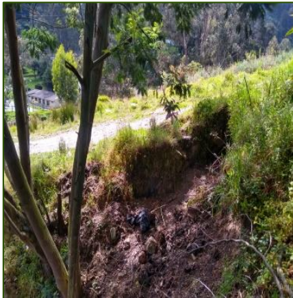
Ilustración 3-96 Carcavamiento del escarpe lateral por entrada de agua desde la vía
