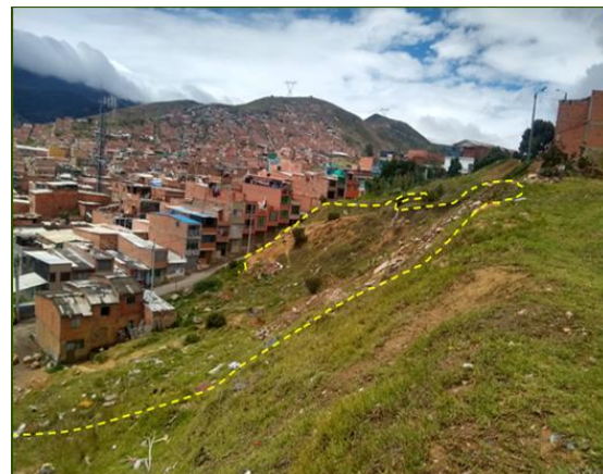
Ilustración 3-125 Escarpe superior del proceso principal
