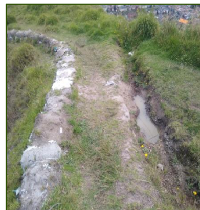
Ilustración 3-145 Estado actual de la obra
