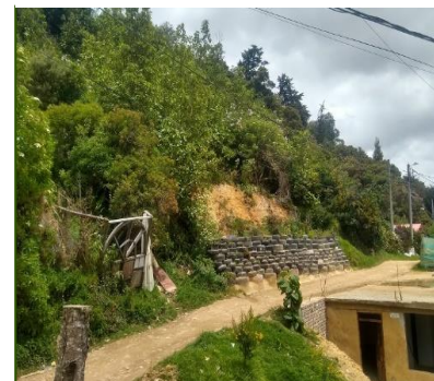
Ilustración 3-47 Muro de llantas construido por la comunidad. Pata del proceso del costado occidental
