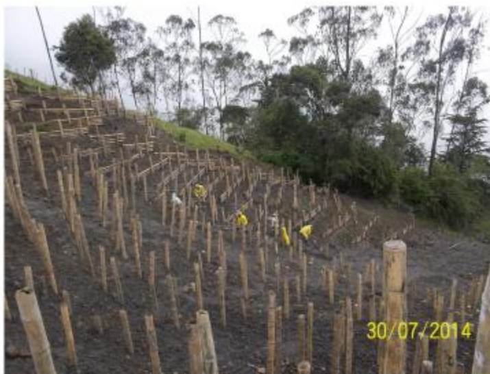
Reconformación de la ladera, talud inferior, sitio El Carmen.
