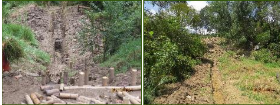
Ilustración 2-135 Canal abierto con disipadores - Canal Terminado
