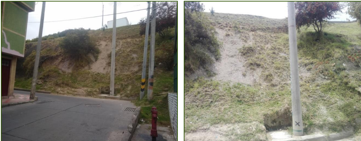
Ilustración 3-119 Vista panorámica del proceso principal al inicio del talud
