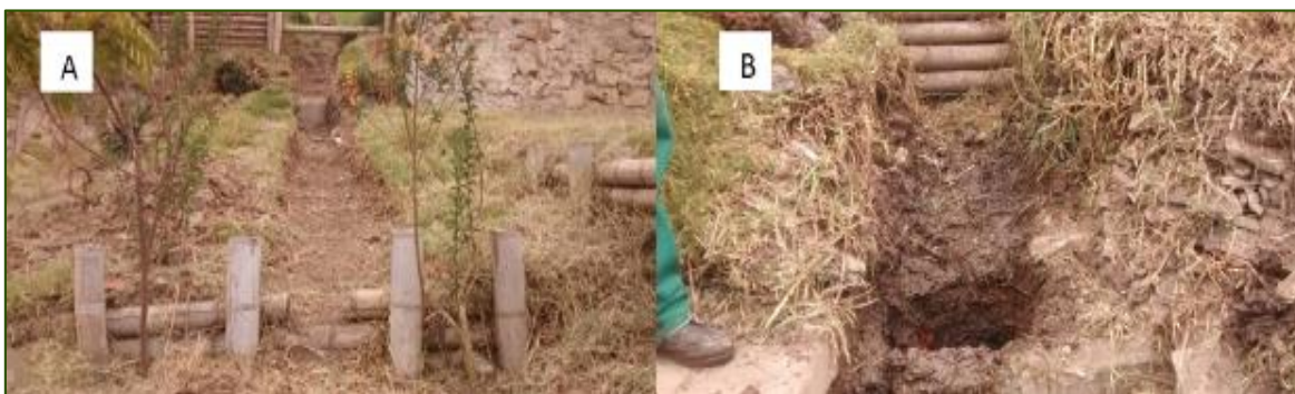
Ilustración 2-60 Mantenimiento de filtro vivo tipo i a) y b) mantenimiento de filtro vivo tipo i.
