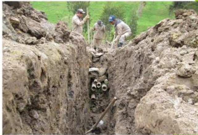
Filtro vivo en construcción, sitio El Carmen.
