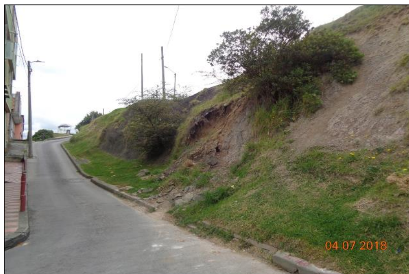
Ilustración 3-101 Vista panorámica del talud completo
