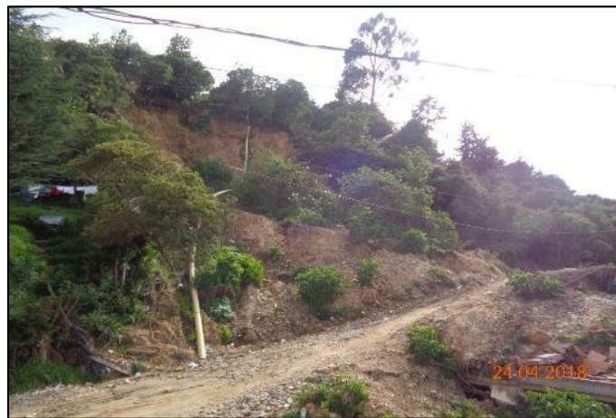
Ilustración 3-35 Vista general del proceso de remoción en masa
