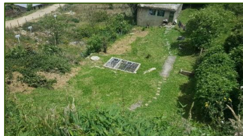
Ilustración 2-46 Desarenador obra de bioingenieria
