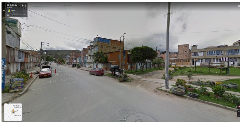
Foto 4. Viviendas de la cuenca de la quebrada Chiguaza
