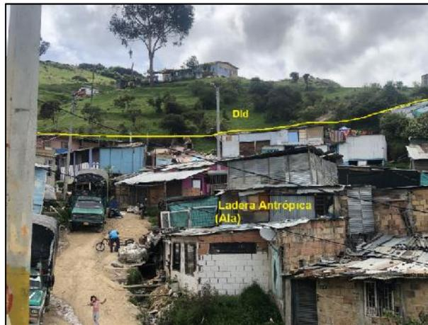
**Fotografía 8** Ladera antrópica producto de la intervención de la zona para la construcción de viviendas y vías internas.
