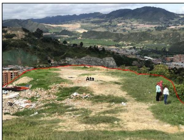
**Fotografía 9** Terraza antrópica localizada en la parte alta de la zona de estudio, sobre la que se lleva a cabo la deposición de escombros.
