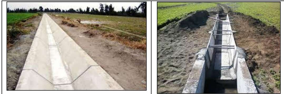
Figura 3. Canales y/o Zanjas de coronación Fuente: (Cooperación técnica Alemana, 2006)
