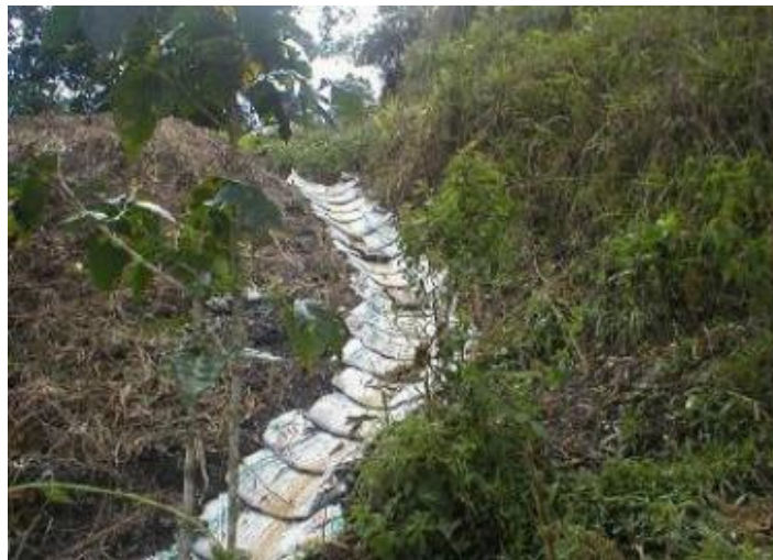
Figura 4. Canales de sacos de suelo Fuente: (Corporación autónoma regional del centro de Antioquía- CORANTIOQUÍA, 2011)
