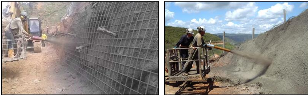
Figura 5. Concreto lanzado. Fuente: (Diaz, 1998)
