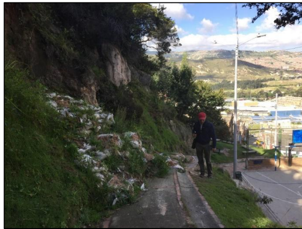
Fotografía 19. Sendero peatonal invadido por caída de bloques y obras en saco suelo.
