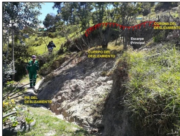
Fotografía 20. Deslizamiento rotacional costado este de la zona de estudio, involucrando materiales de relleno.
