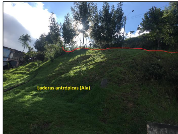
Fotografía 10. Ladera Antrópica localizada en la parte baja del parque infantil al noreste del talud en estudio - Parque Barrio El Porvenir Fuente: consorcio Himec – Consulcons, 2018
