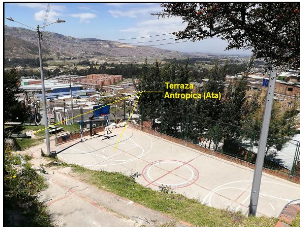
Fotografía 12. Terraza Antrópica generada para la construcción del campo deportivo, localizada hacia la parte baja de la zona de estudio Fuente: Consorcio Himec – Consulcons, 2018
