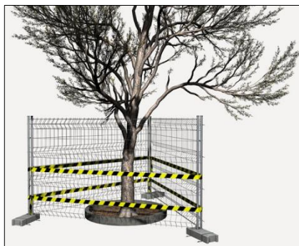
Figura 7. Barrera de protección.
