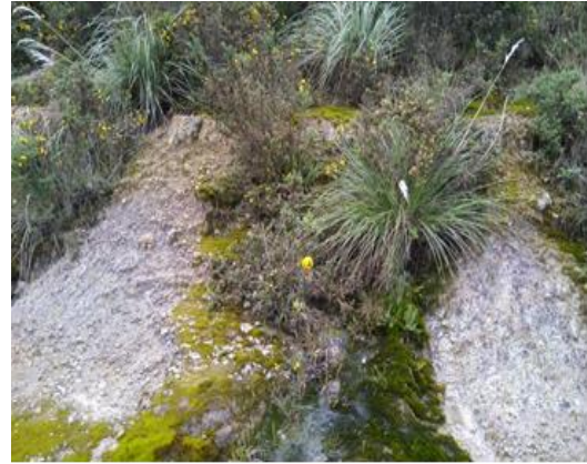
FOTO 7.20 FRENTES DE INCUBACIÓN DE SURCOS DE EROSIÓN: COINCIDEN CON PEQUEÑOS NACEDEROS SUBSUPERFICIALES QUE EMANAN EN EL CONTACTO DE LAS LODOLITAS Y DE LAS ARENISCAS
