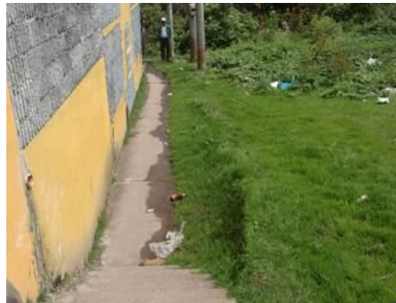
FOTO 6.4 FOCOS DE HUMEDAD EN LA FRANJA NORORIENTE DEL PREDIO 64 DE LA MANZANA 78.
