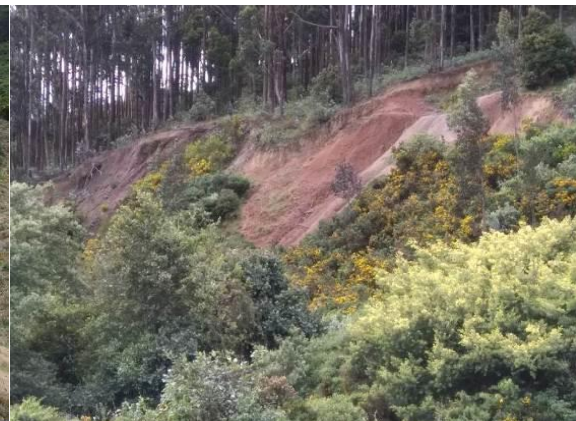
FOTO 7.23 FRENTES DE EROSIÓN LAMINAR EN LAS LADERAS DEL NORTE Y DEL NORORIENTE
