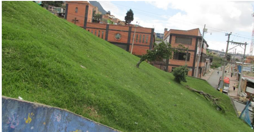
FOTO 7.15 CORTE OCCIDENTAL DEL PARQUE: LOS ABOMBAMIENTO Y LA INCLINACIÓN DE LOS ÁRBOLES PERMITEN INFERIR LA INCUBACIÓN DEL DESLIZAMIENTO
