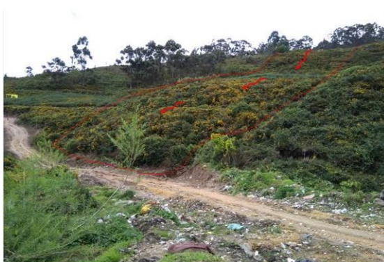
FOTO 7.1 EXPRESIÓN MORFOLÓGICA DE LA PATA DEL DESLIZAMIENTO PRINCIPAL
