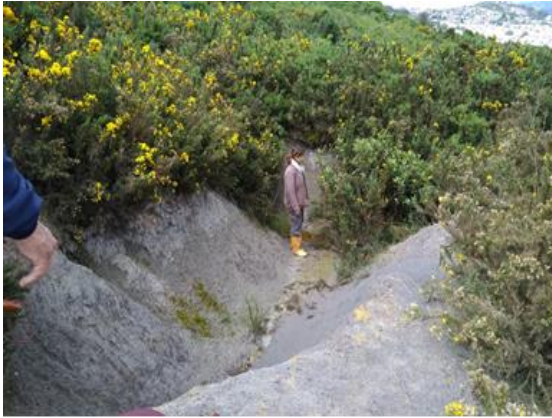
FOTO 7.19 CÁRCAVAS LABRADAS EN LAS LODOLITAS: SU PROFUNDIDAD SUPERA EL METRO, Y SE EXPONEN EN LA VERTIENTE DERECHA DE LA MICROCUENCA. EL FLUJO EMANA POR LAS PARECES DE LA CÁRCAVA.
