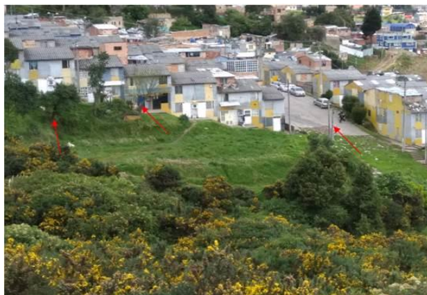
FOTO 7.5 PANORÁMICA DEL FOCO DE DESLIZAMIENTO 2. LA VEGETACIÓN Y LA RED ELÉCTRICA EXPONEN LAS HUELLAS DEL MOVIMIENTO.
