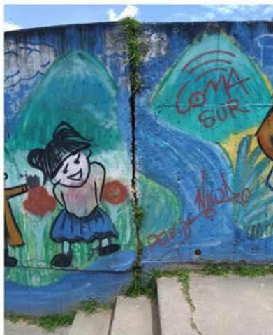
FOTO 7.16 ABERTURAS Y DESPLAZAMIENTOS EN EL MURO DE CONTENCIÓN DEL PERÍMETRO NORTE DEL PARQUE Y GRIETAS VERTICALES Y HORIZONTALES EN LOS MUROS DE CONFINAMIENTO Y EN LAS ESCALERAS.
