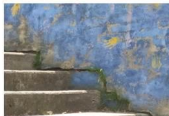
FOTO 7.16 ABERTURAS Y DESPLAZAMIENTOS EN EL MURO DE CONTENCIÓN DEL PERÍMETRO NORTE DEL PARQUE Y GRIETAS VERTICALES Y HORIZONTALES EN LOS MUROS DE CONFINAMIENTO Y EN LAS ESCALERAS.
