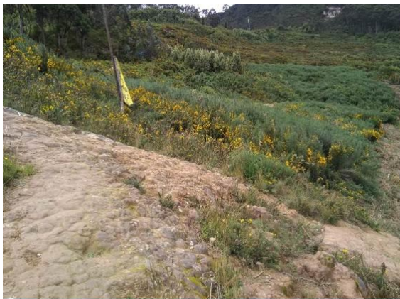
FOTO 7.22 FRENTE DE EROSIÓN 2: ES DE TIPO LAMINAR Y SE CIRCUNSCRIBE EN LAS INMEDIACIONES DEL SEGUNDO FOCO DE INESTABILIDAD.
