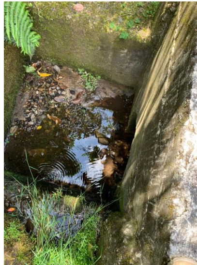
Fotografía 5. Se evidencia muro de acompañamiento, muro cabezal, guarda ruedas y solado. Se tienen dos tuberías en concreto con un diámetro de 24"
