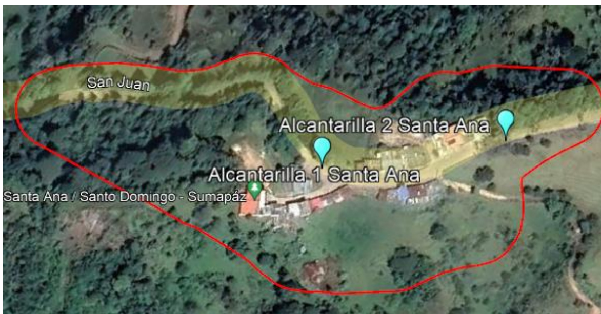
Figura 44. Alcantarillas existentes en el nodo Sana Ana Fuente: Geodinámica
