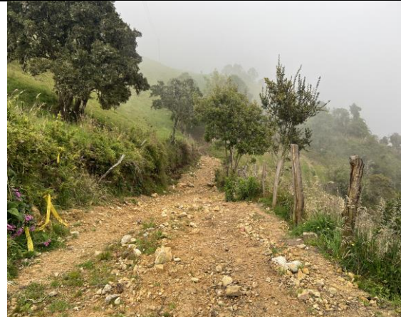
Fotografía 23 Acceso vial encontrado dentro del polígono, el cual presenta altas pendientes.
