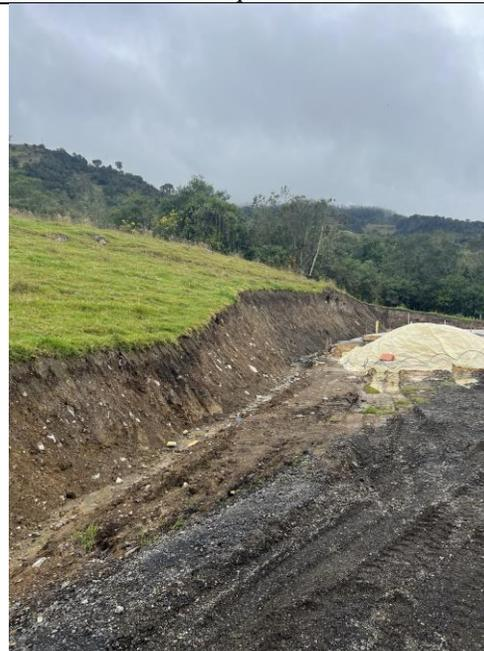
**Fotografía 16.** Corte en el terreno, el cual no cuenta con protección ni estructura de contención
