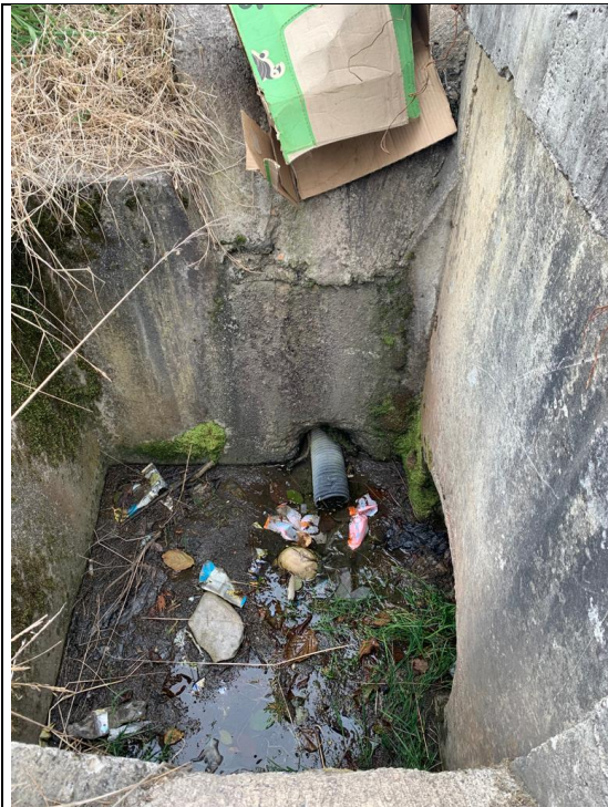
Fotografía 12. Se observa que el alcantarillado presenta muro de acompañamiento, zanja, guardarruedas y sol
