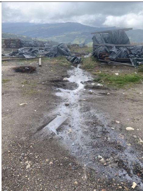
Fotografía 24. Zanja vial, mal manejo de aguas
