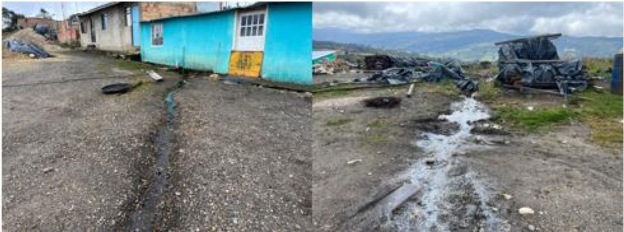
Fotografía 16. manejo inadecuado de aguas lluvias y residuales, nodo Tunal Alto Fuente: Geodinámica
