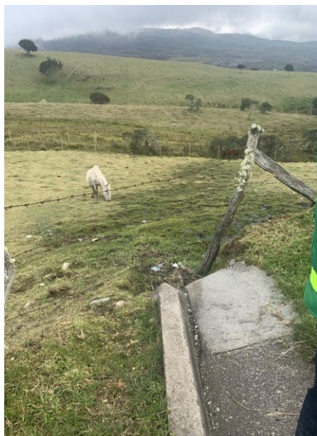
Fotografía 24. Zanja vial, mal manejo de aguas
