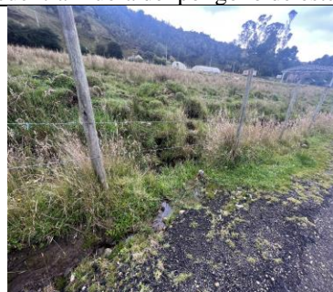
Fotografía 30 Zonas de infiltración.
