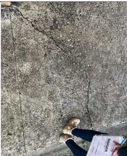
Fotografía 25 Grietas presentadas en el costado derecho del edificio de profesores.
