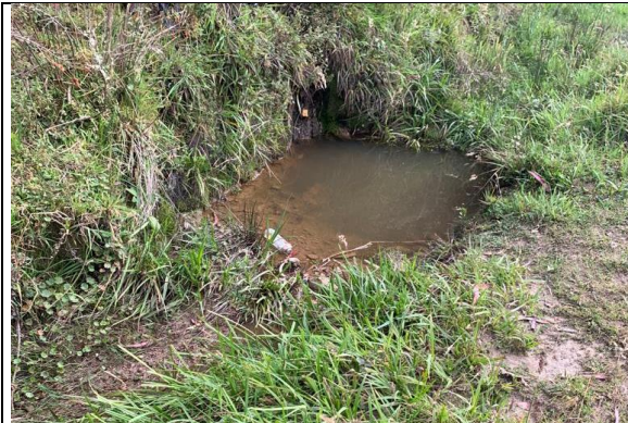
Fotografía 8. Empozamiento de agua por alcantarilla obstruida.
