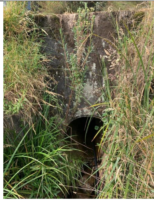
Fotografía 9. Se tiene una tubería en concreto con un diámetro de 24"
