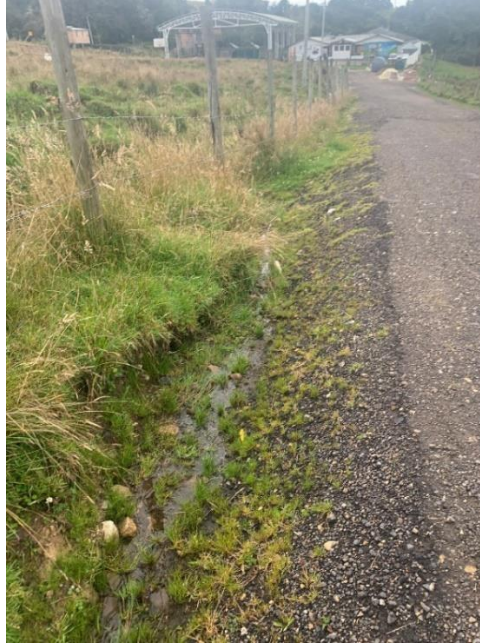
Fotografía 19. Zanja vial, nodo las Vegas Fuente. Geodinámica
