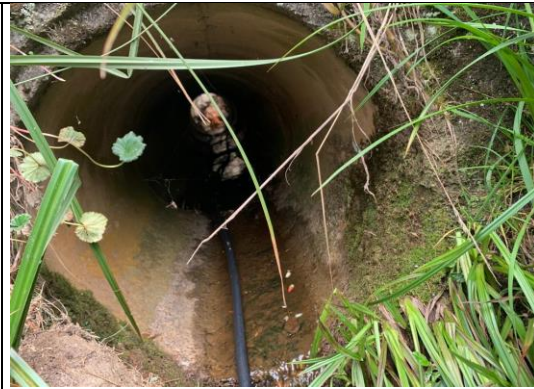
Fotografía 9. Se tiene una tubería en concreto con un diámetro de 24"
