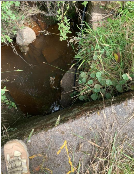
Fotografía 8. Empozamiento de agua por alcantarilla obstruida.
