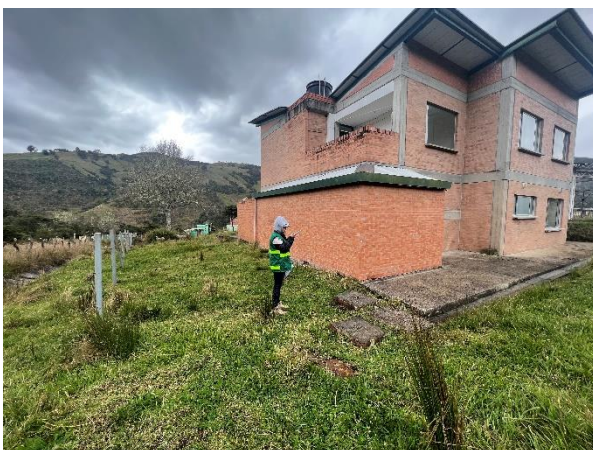
Fotografía 5. Infraestructura de Institución educativa (Áreas culturales).
