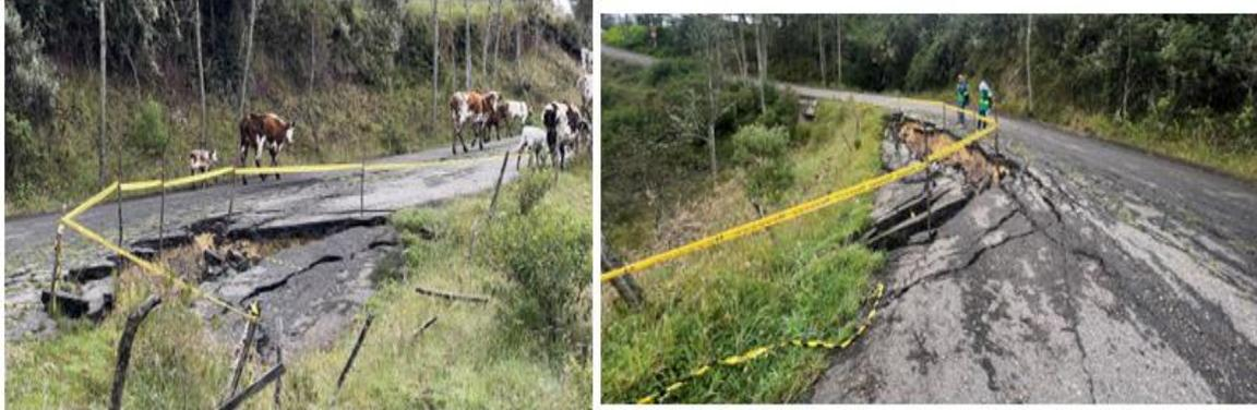
**Figura 31. Proceso de remoción en masa que afecta la banca de la vía.**
