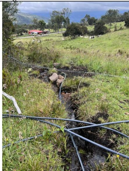
**Fotografía 25. Zanja artificial para suministro de agua en las viviendas bajas**
