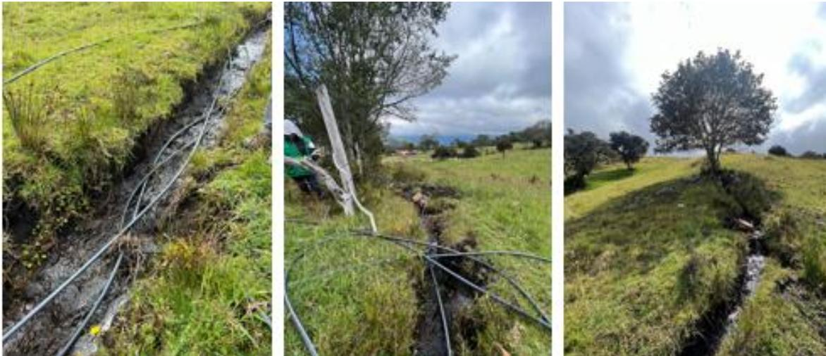
**Fotografía 16. Zanja artificial que suministra agua a las construcciones bajas del nodo Concepción**
