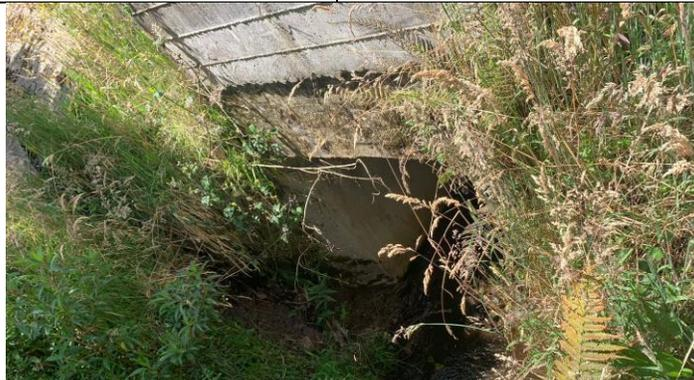
**Fotografía 9.** No existe presencia de aletas ni encole para el box colvert
