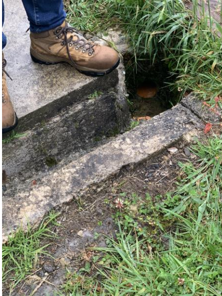
Fotografía 34 Drenaje no controlado que cae al talud.
