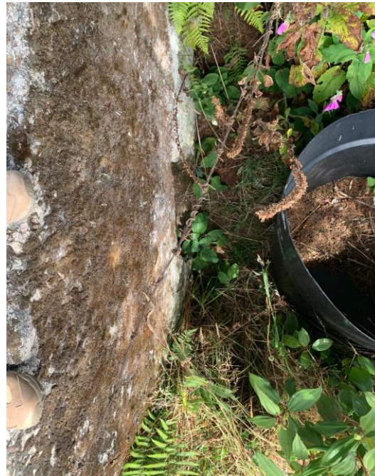
Fotografía 13. La tubería de la alcantarilla es de concreto y tiene un diámetro de 24"
