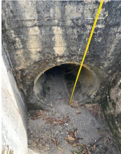
Fotografía 12. La alcantarilla está equipada con muro cabezal, muro de acompañamiento y solado
