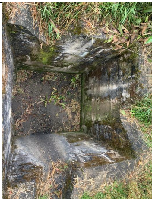
Fotografía 20. Se evidencia el muro cabezal y muros de acompañamiento
