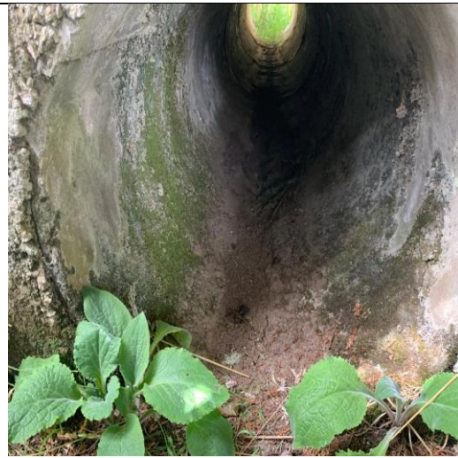
Fotografía 13. La tubería de la alcantarilla es de concreto y tiene un diámetro de 24"
