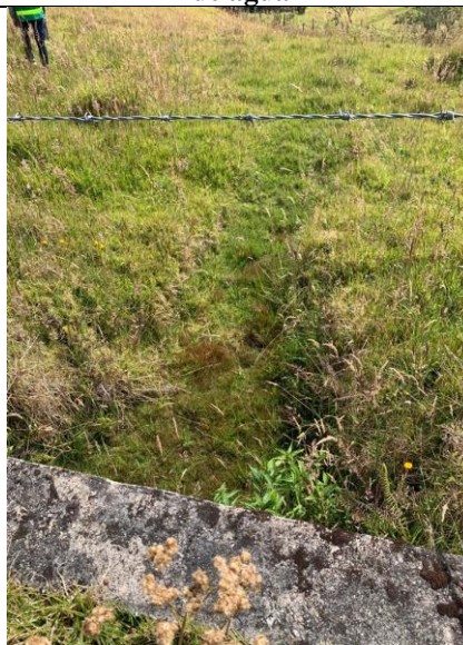
Fotografía 9. La tubería de la alcantarilla es de 24 ", se evidencia taponamiento por falta de mantenimiento, lo que genera empozamiento de agua
