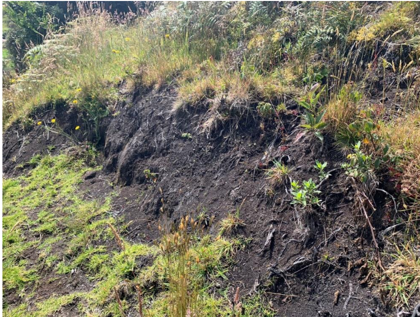
Figura 31. Parte alta del deslizamiento rotacional presente en la ladera inferior aledaña al polideportivo.
