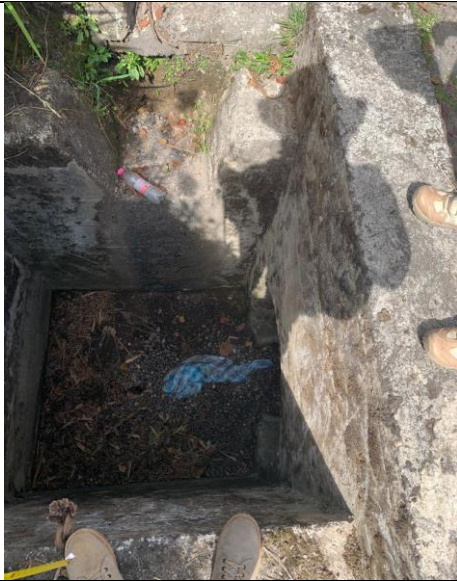
Fotografía 16. Se evidencia muro de acompañamiento y muro cabezal
