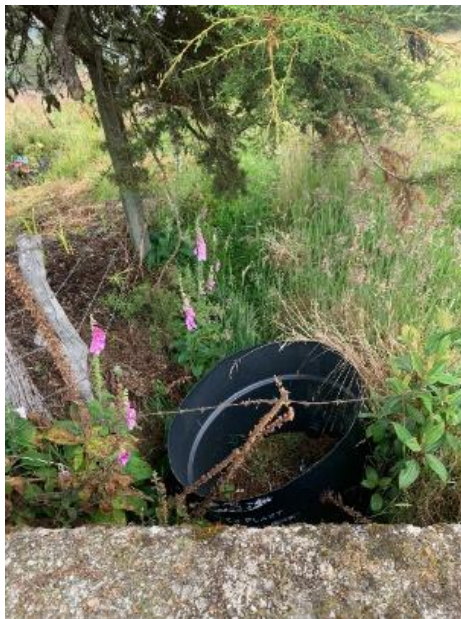
Fotografía 34 Drenaje no controlado que cae al talud.
