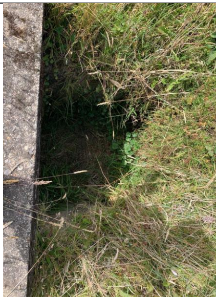
Fotografía 10. No se cuenta con un descole apropiado, por lo cual las aguas recogidas por esta alcantarilla se vierten al terreno natural,
