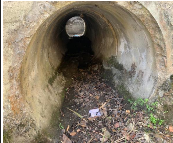
Fotografía 17. Se tiene una tubería en concreto con un diámetro de 30"
