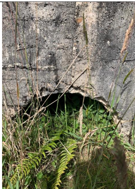
Fotografía 9. La tubería de la alcantarilla es de 24 ", se evidencia taponamiento por falta de mantenimiento, lo que genera empozamiento de agua
