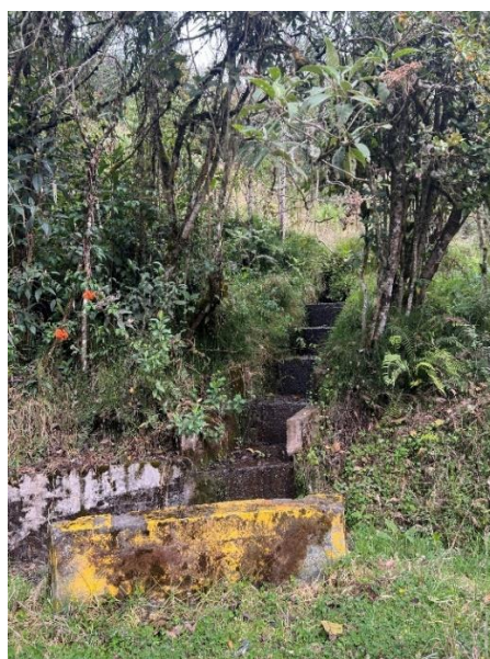
Fotografía 29. Dissipador de energía escalonado- vía el Raizal- las Animas. Fuente Geodinámica
