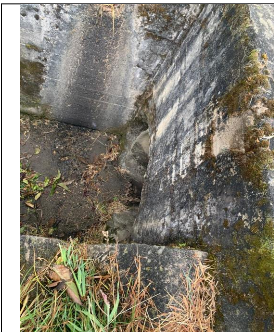
Fotografía 19. La tubería de la alcantarilla es de concreto, con diámetro de 40"
