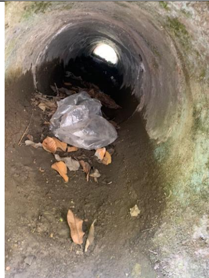
Fotografía 24. Se evidencia que esta esta colmatada por falta de mantenimiento
