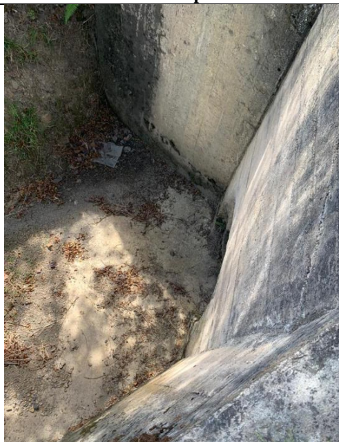
Fotografía 22. Se cuenta con solado, aletas y muro cabezal
