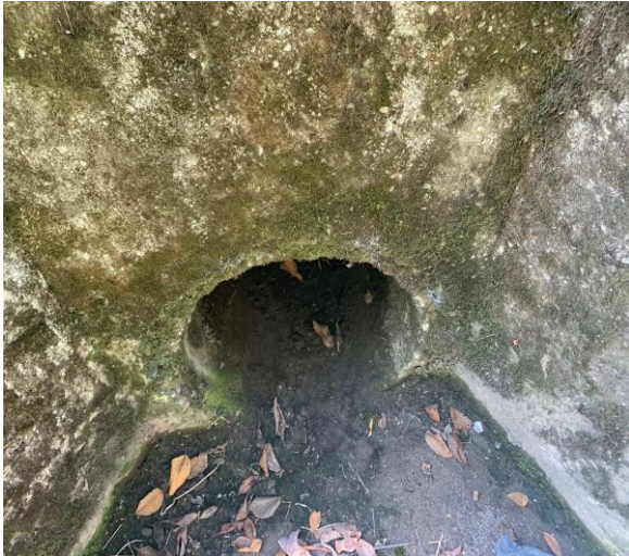
Fotografía 23. La tubería de la alcantarilla es de concreto, con diámetro de 24"
