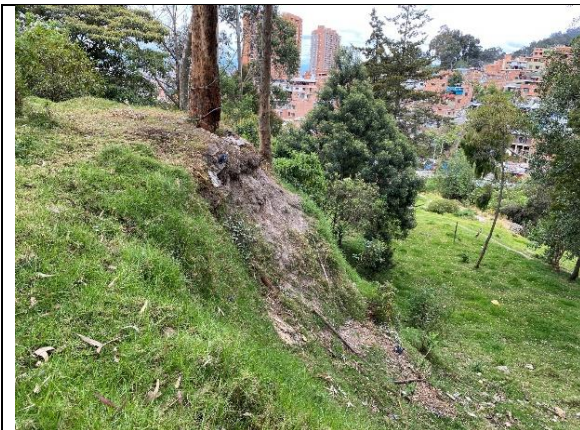
Figura 26. Talud en lote IDU, registro de movimiento anterior véase capítulo 6. 4°38'21.95"N, 74° 3'15.47"O
