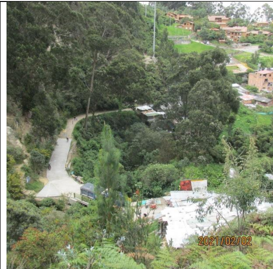
Fotografía 7 – Vista hacia aguas debajo de la quebrada Las Delicias en el cruce con la Transversal 5 E, se aprecia el puente vehicular construido y viviendas en la margen derecha del cauce.
