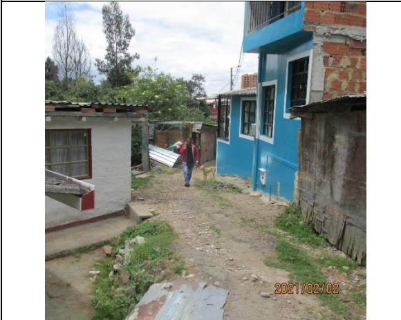
Figura 28. Presencia de viviendas en la zona de ronda de la quebrada. Margen derecha. 4°38'18.83"N, 74° 3'11.21"O
