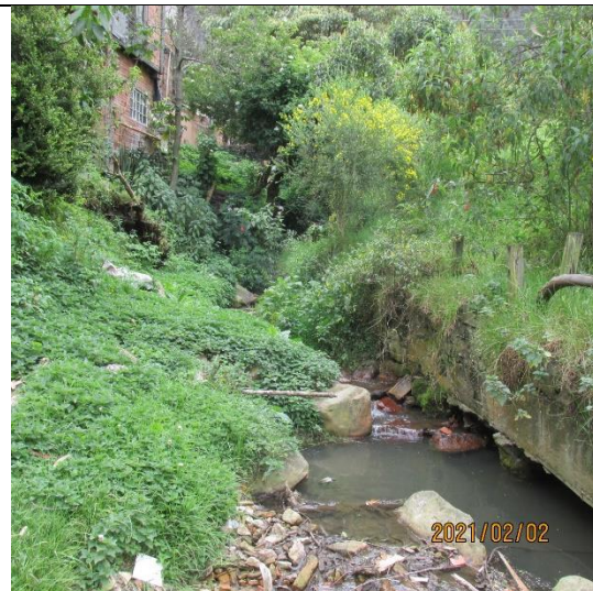
Fotografía 10 – Vista hacia aguas arriba del Cauce de la quebrada las Delicias, se aprecia sección reducida debido a la construcción de casas en la margen derecha y muro en concreto en la margen izquierda.
