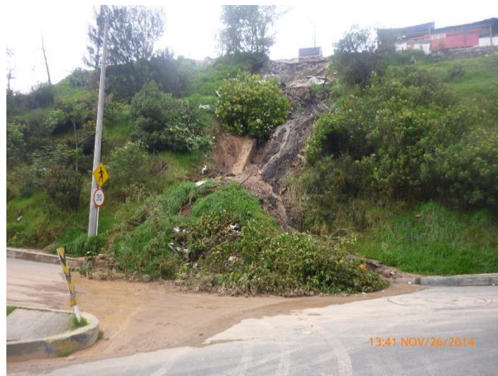
Figura 7. Fotografía asociada con la falla del talud en la Transversal 4 Este con Diagonal 57. DI-7695. Noviembre de 2014. FOPAE (2014)
