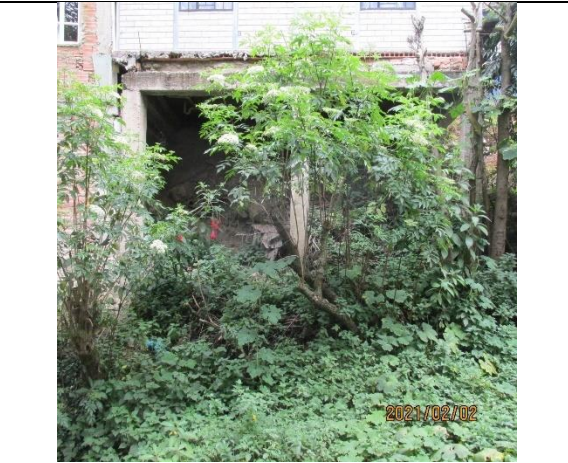
Figura 29. Viviendas construidas con palafitos en concreto que se apoyan directamente sobre la zona del cauce de la quebrada Las Delicias (margen derecha). 4°38'20.67"N, 74° 3'13.16"O
