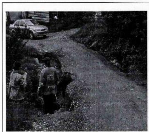
Figura 9. Vista general del pontón que se encuentra sobre la Transversal 5 Este en el cruce con la Quebrada Las Delicias. DI-9848. Noviembre 16 de 2016. IDIGER (2016)
