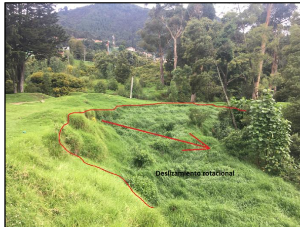
Fotografía 10. Panorámica del Cono o lóbulo de deslizamiento rotacional. Fuente: Consorcio Himec – Consulcons, 2018
