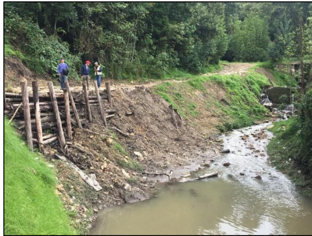
Fotografía 21. Detalle de contención con micro pilotes de madera en la pata del deslizamiento.
