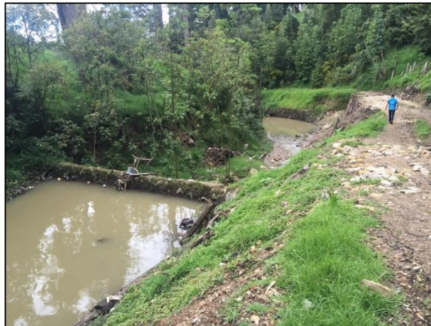
Fotografía 22. Detalle de los sedimentadores en el río Arzobispo.
