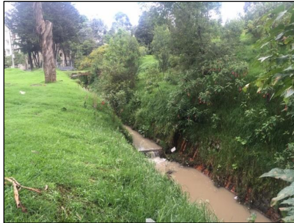
Fotografía 20. Detalle del canal Cataluña
