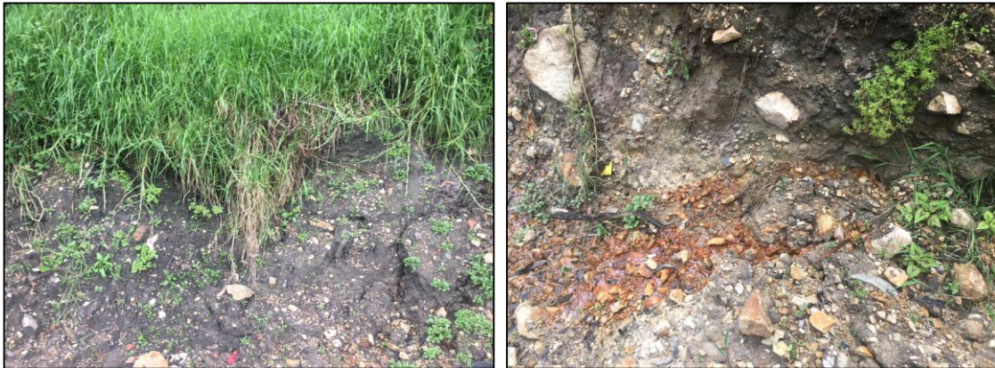
Fotografía 16. Afloramiento de agua sub-superficial en suelos remoldeados, a media ladera (izquierda) y en la pata de la ladera (derecha). Fuente: Consorcio Himec – Consulcons, 2018
