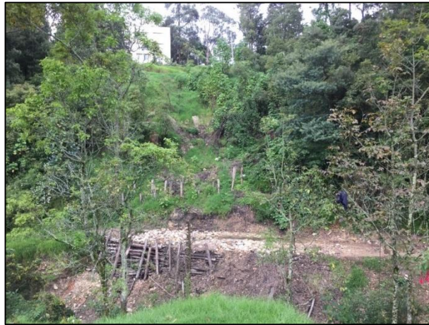
Fotografía 23. Panorámica del sitio de deslizamiento y estructura de contención en madera de la vía de acceso al río Arzobispo.
