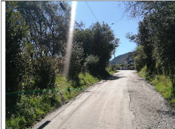
Figura 30. Vía principal de acceso al Nodo de Equipamiento de Quiba Alta. Se observa una estructura en pavimento flexible.
