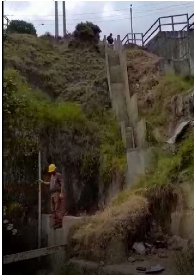
Figura 63 Fotografía estado actual de canal escalonado
