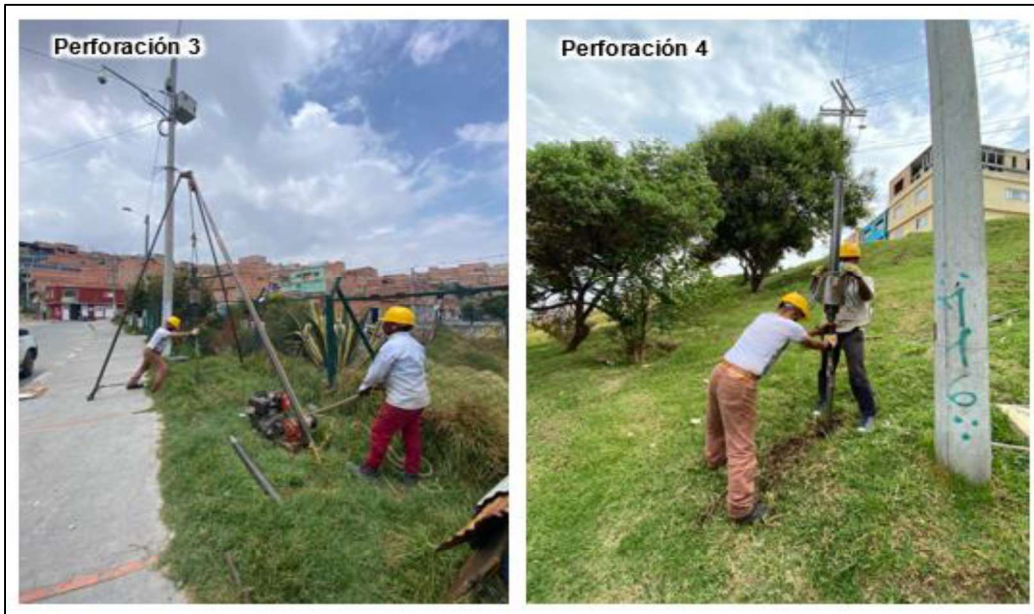
Figura 77 Registro fotográfico Perforación 3 y 4
