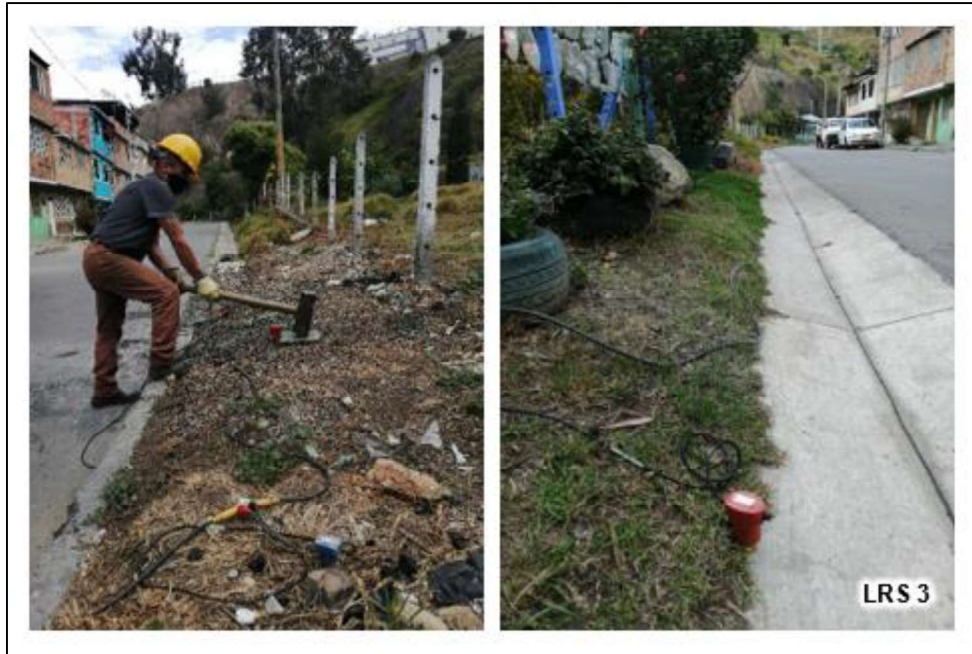
Figura 94 Registro fotográfico LRS 3
