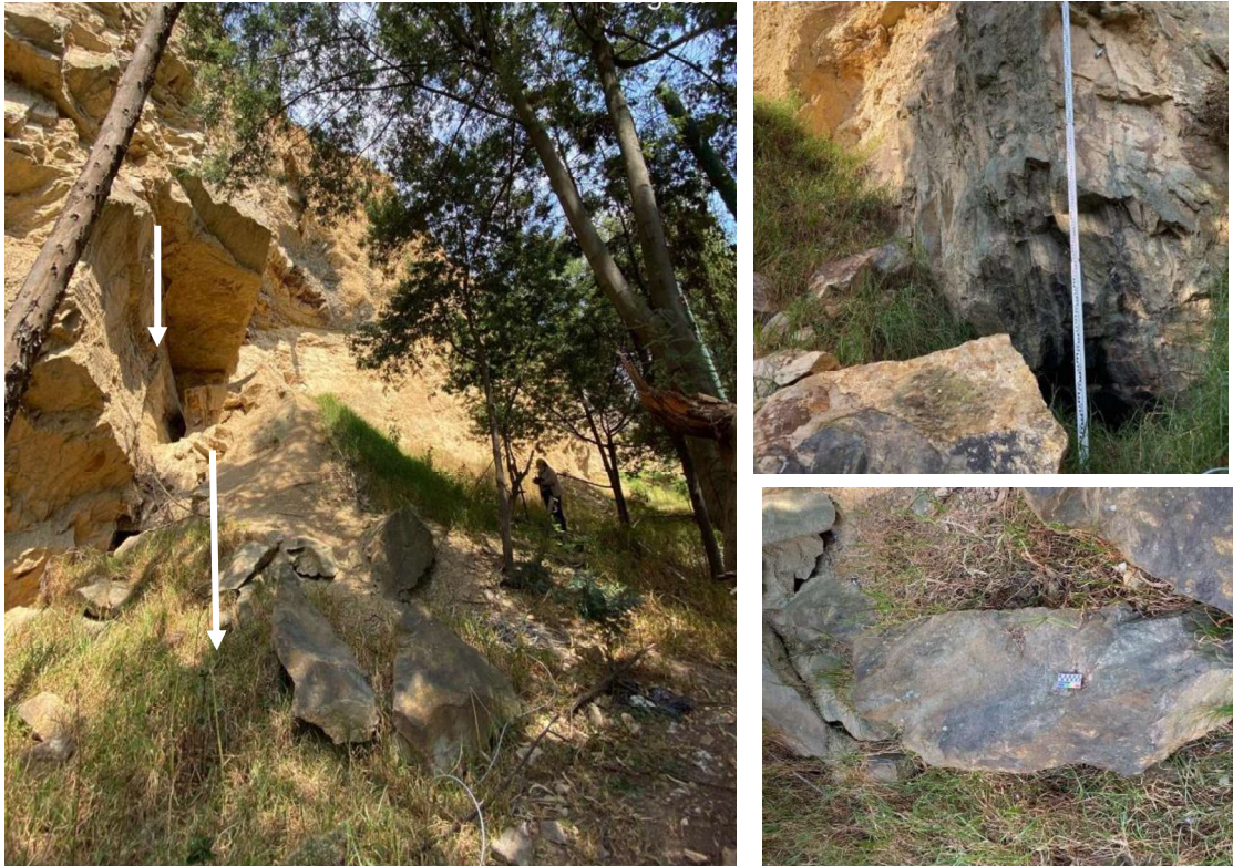
Figura 42 Movimiento en masa N°2 tipo caída de rocas
