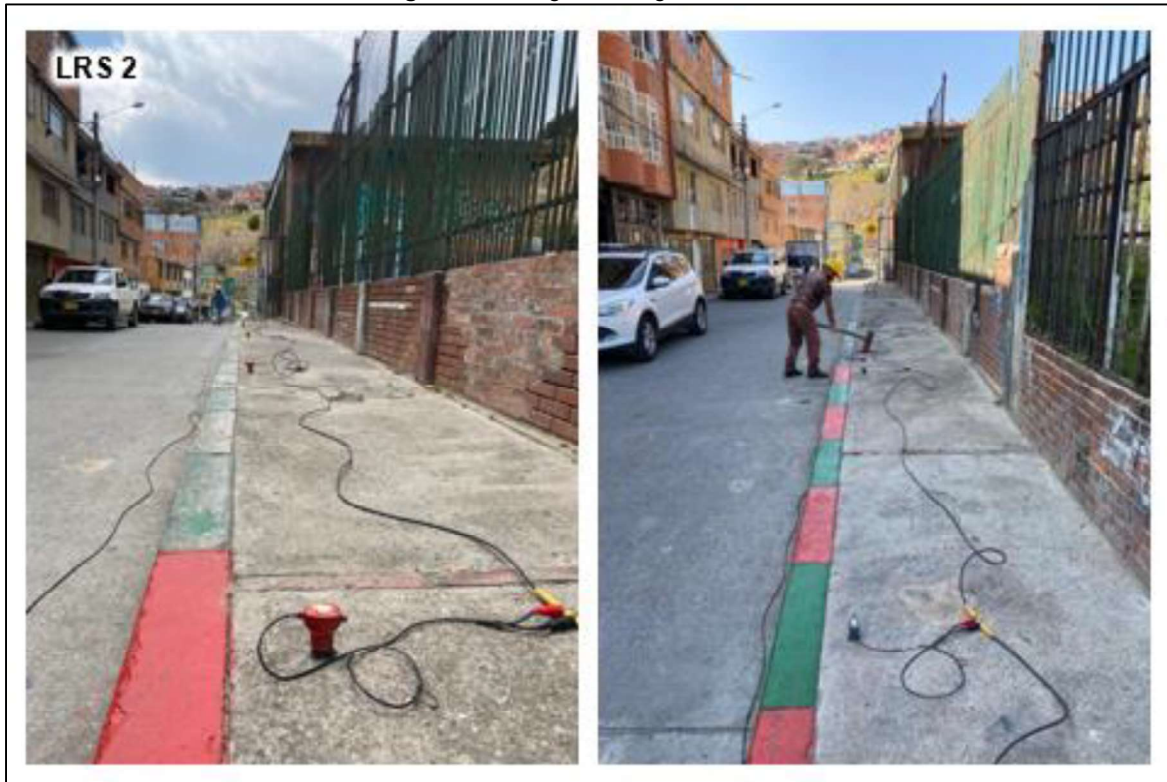
Figura 93 Registro fotográfico LRS 2
