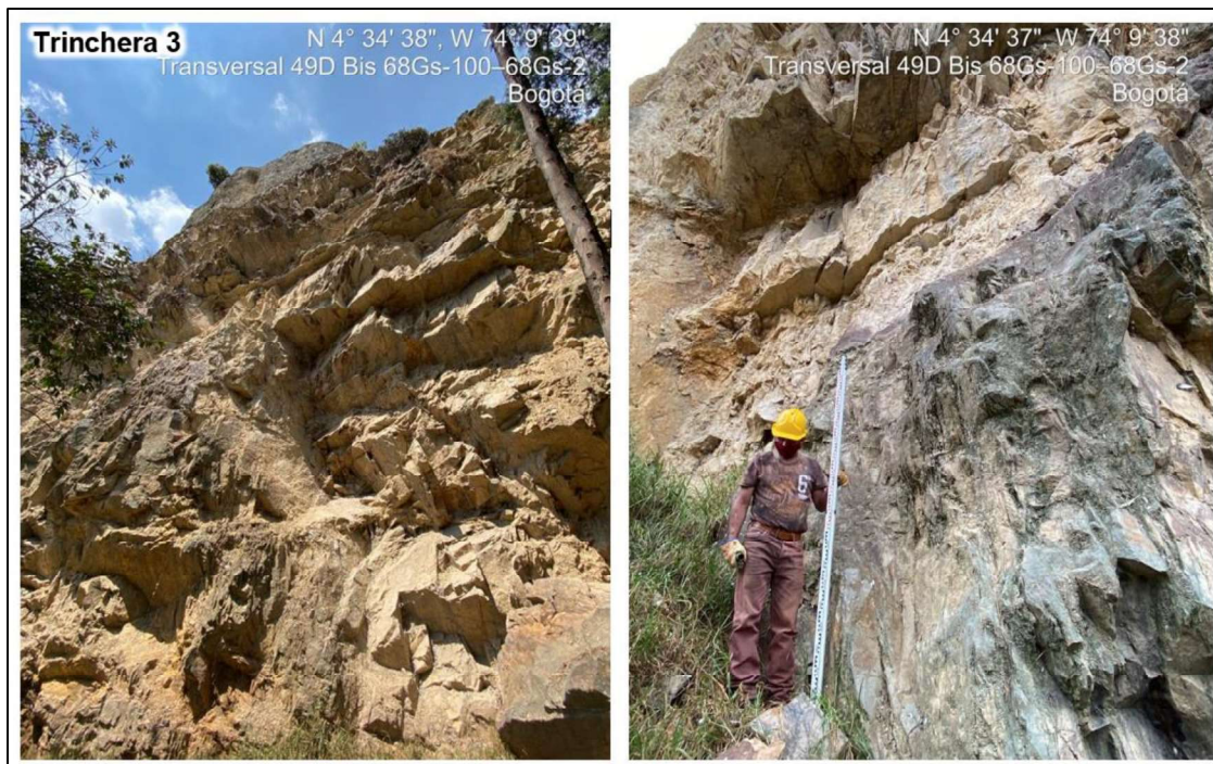
Figura 91 Registro fotográfico Trinchera 3
