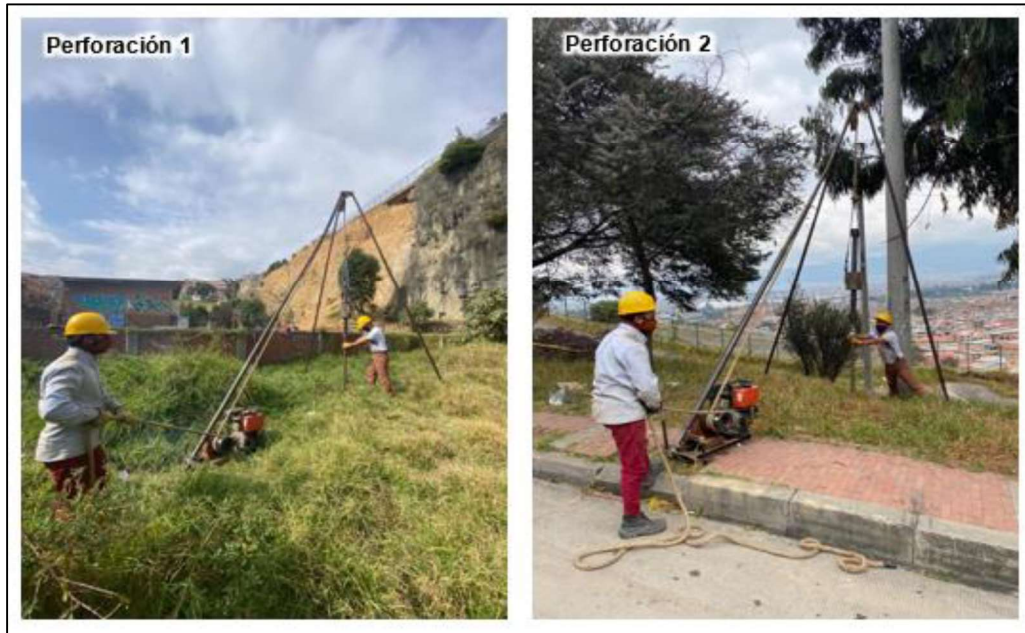
Figura 76 Registro fotográfico Perforación 1 y 2
