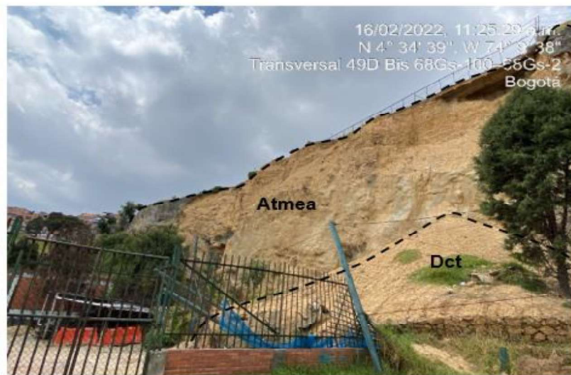
Figura 36 Talud de corte muy escarpado activo y cono de talus
