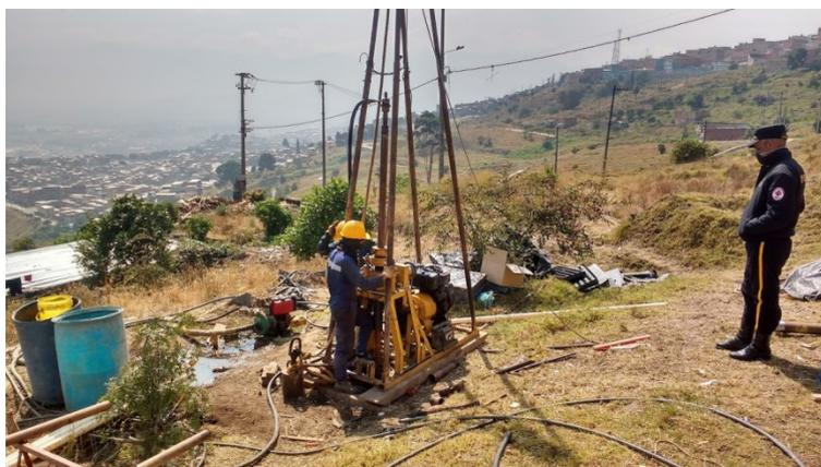
*Imagen 133 Equipo de perforación localizado en el sondeo IUD14*
