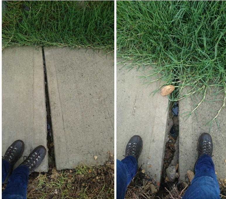
*Fotografía 22 Separación de los elementos estructurales de la cuneta y apozamiento de agua residual*
