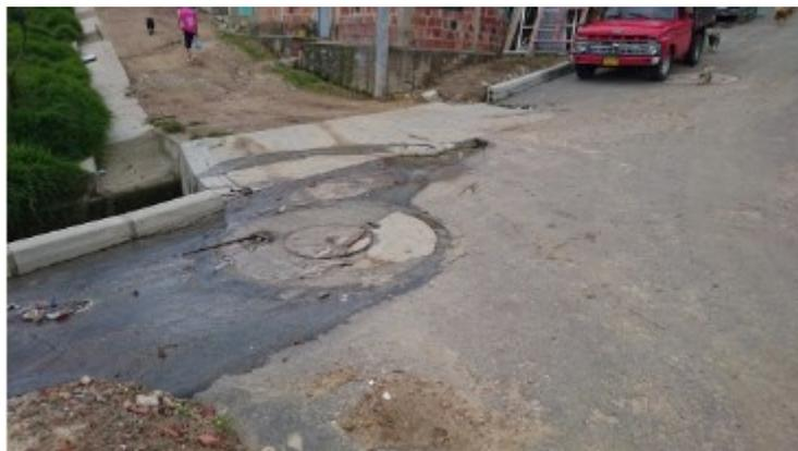
Imagen 68 Punto crítico rebosamiento pozo alcantarillado
