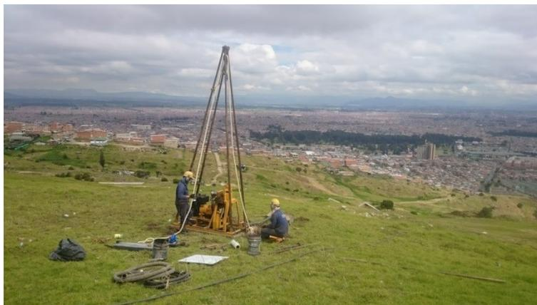
*Imagen 123 Equipo de perforación localizado en el sondeo IUD4*
