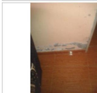
Descascaramiento de la pared por humedad.
