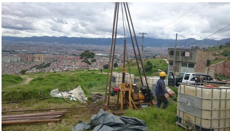
*Imagen 121 Equipo de perforación localizado en el sondeo IUD1*
