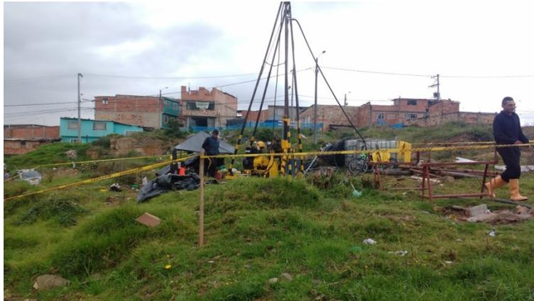
Imagen 134 Equipo de perforación localizado en el sondeo IUD15
