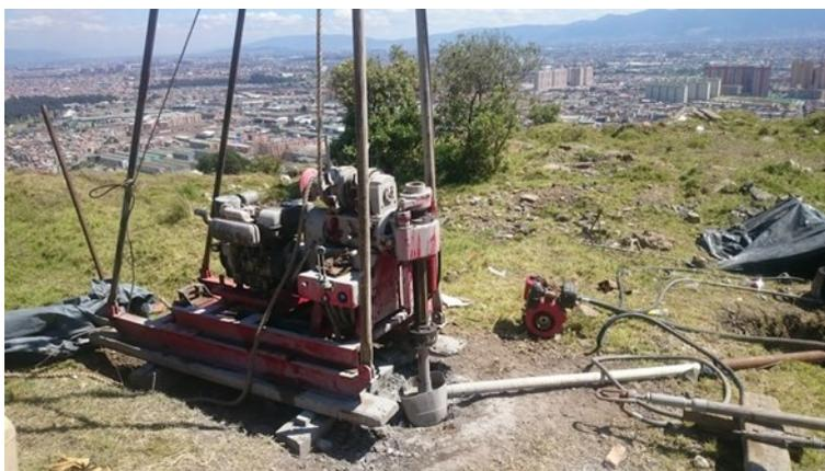
*Imagen 124 Equipo de perforación localizado en el sondeo IUD5*
