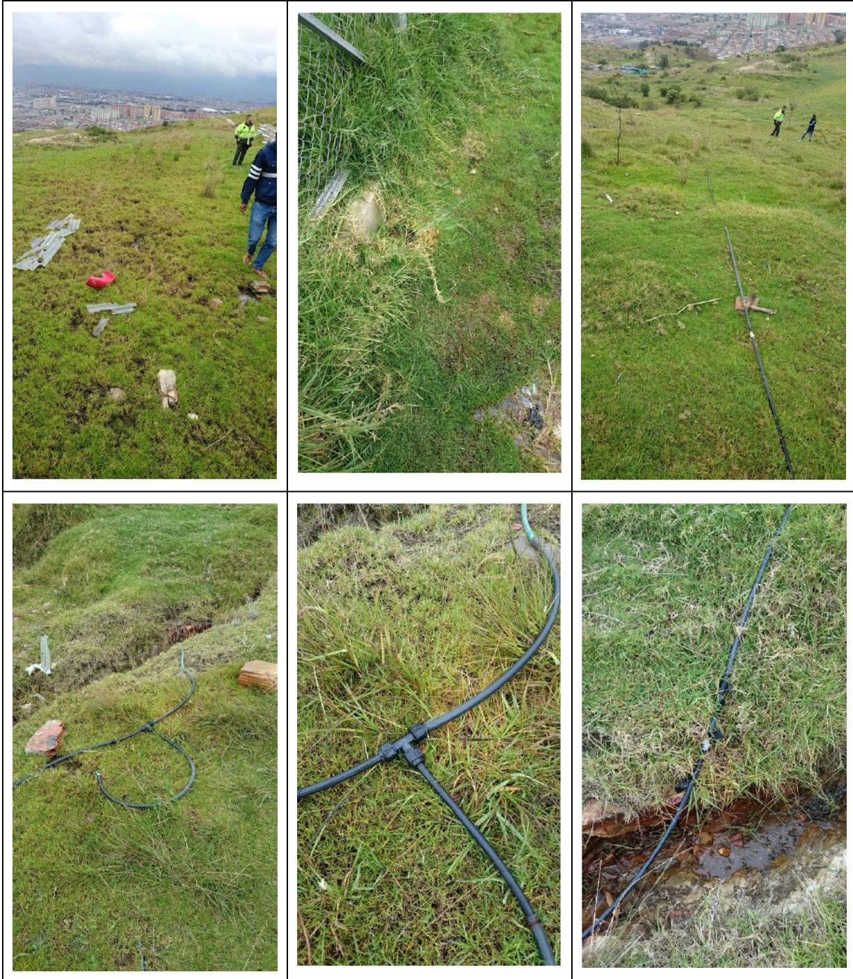
Imagen 63 Zona húmeda por conexiones de agua potable
