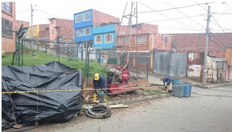
*Imagen 126 Equipo de perforación localizado en el sondeo IUD7*
