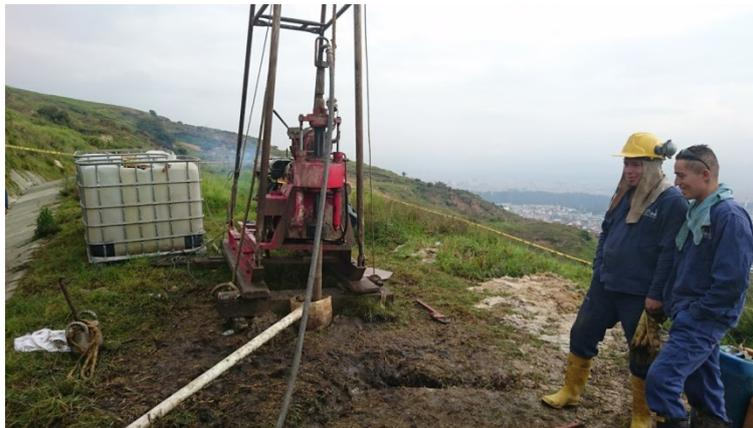
*Imagen 122 Equipo de perforación localizado en el sondeo IUD2*
