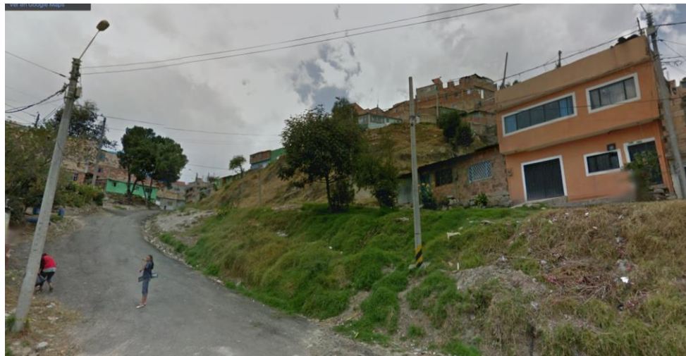
Figura 6 Localización área de intervención de estudio JERUSALEN SANTA ROSITA LAS VEGAS Fuente: Foto consorcio HIMEC-CONSULCONS
