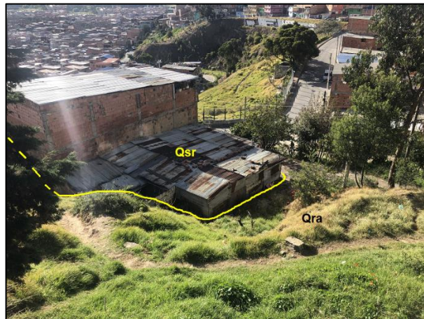
Fotografía 4 Suelo residual sobre el cual se cimentaron algunas viviendas del Sector Santa Rosita – Las Vegas, al noreste de la zona de interés.
