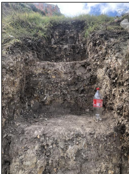
Fotografía 6 Materiales de relleno expuestos en una de las trincheras ejecutadas durante la exploración del subsuelo en el Sector Santa Rosita – Las Vegas.
