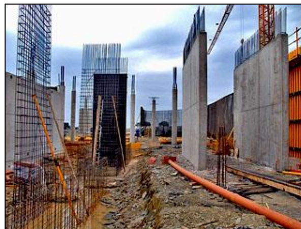
Figura 5 Pantallas en concreto Fuente: (INDIGO CONSTRUCCIONES Ltda, 2012)
