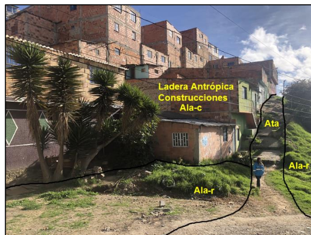
Fotografía 8 Panorámica hacia la Ladera Antrópica - Construcciones localizada en la parte alta del talud de interés en el Sector Santa Rosita – Las Vegas.
