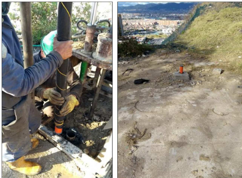
Ilustración 4-27 Registro fotográfico instalación de piezómetro S-2 (JAM S-1 I)
