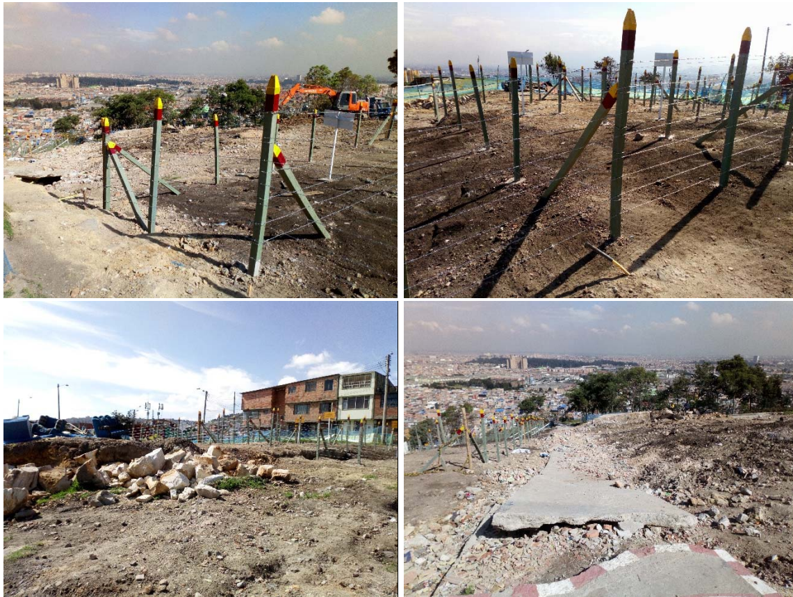
Ilustración 6-2 Fotografías del área de estudio en proceso de reasentamiento de familias y demolición de infraestructura.
