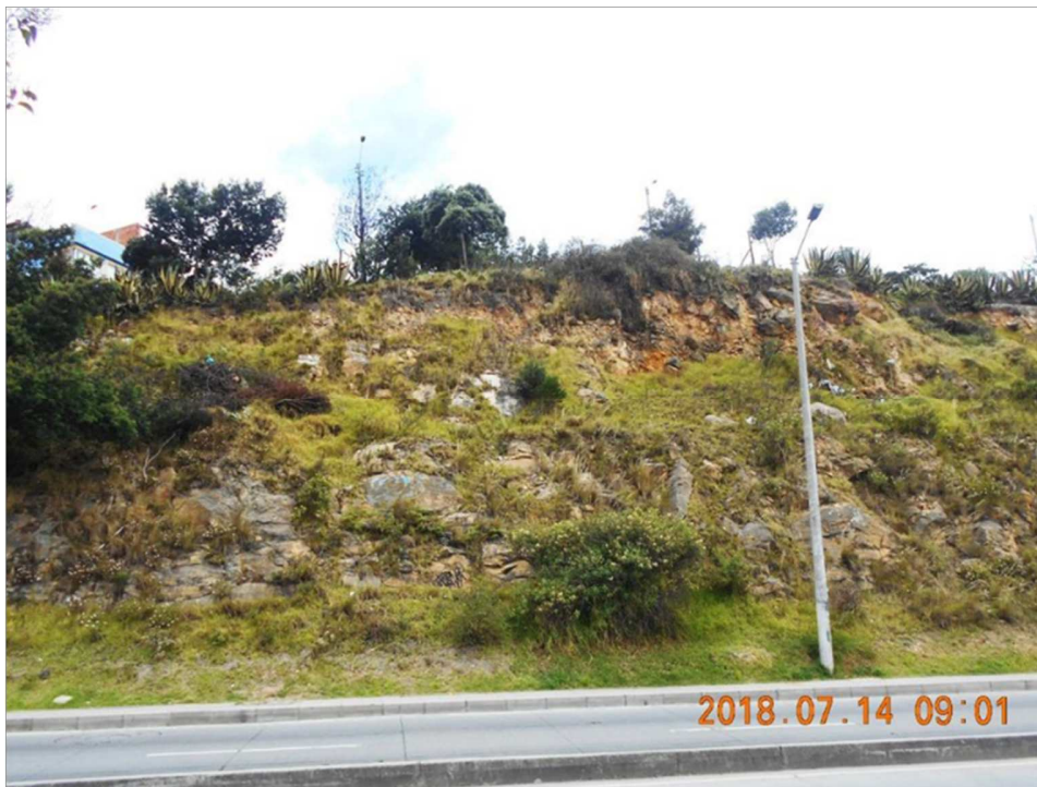
Ilustración 4-45 Unidades de roca en los taludes viales.
