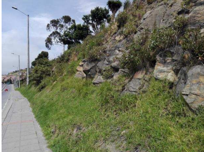
Ilustración 4-80 Aspecto de la zona 5, rocas en contrapendiente estructural
