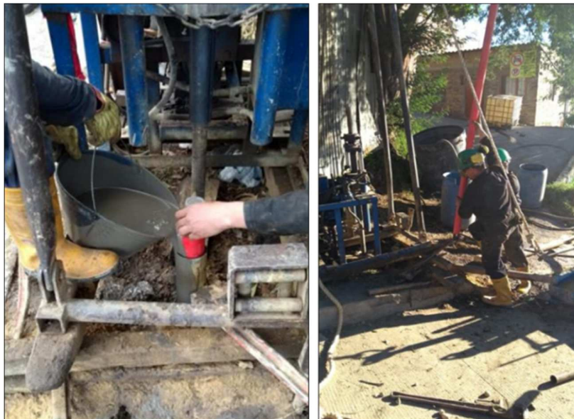
Ilustración 4-29 Registro fotográfico instalación de inclinómetro S-3 (JAM S-5)
