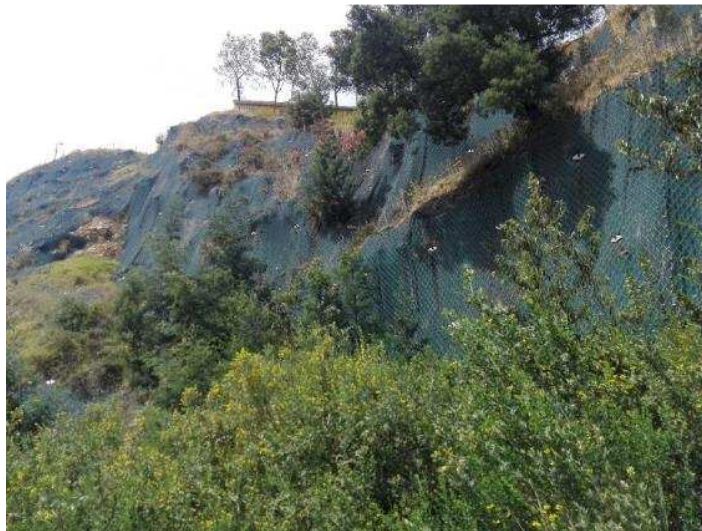
Ilustración 4-77 Aspecto de la parte baja de la zona 1
