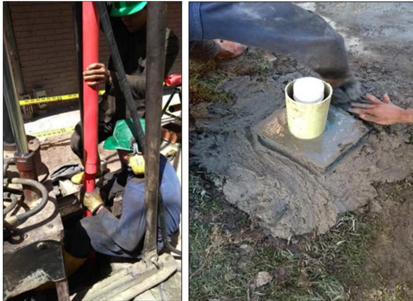
Ilustración 4-28 Registro fotográfico instalación de inclinómetro S-4 (JAM S-2)
