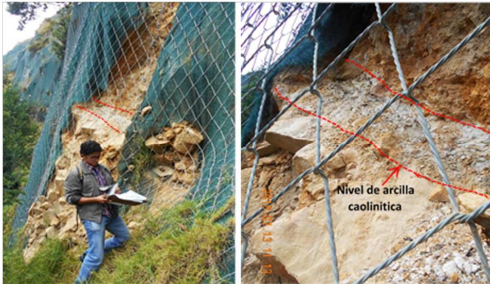
Ilustración 4-47 Afloramiento de nivel de arcilla caolinitica, Talud del antiguo frente de explotación.
