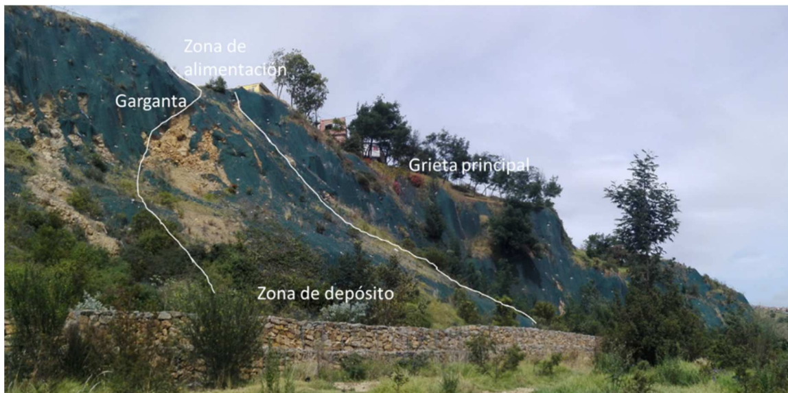
Ilustración 4-53 Clasificación del talud minero. Criterio de experto
