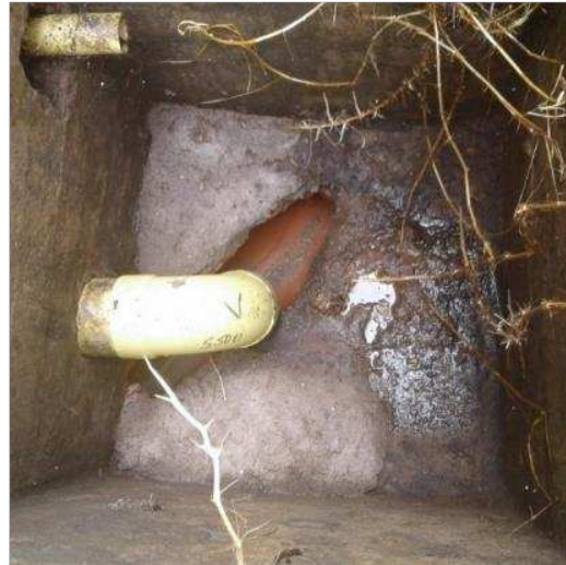
Ilustración 4-98 Acometidas irregulares
