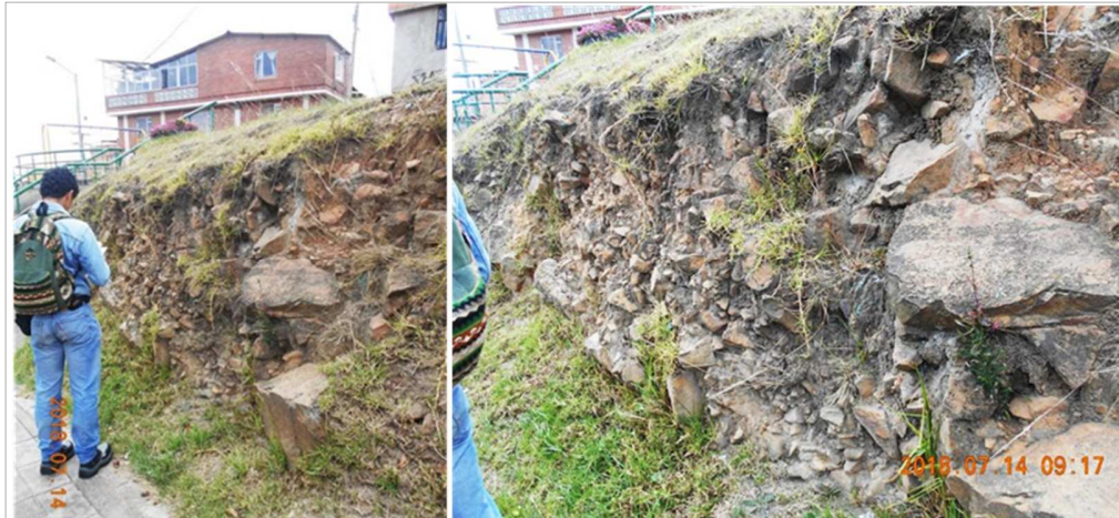
Ilustración 4-42 Afloramiento de arenisca cuarzosa altamente fracturada. Costado derecho, sobre la transversal 60, entre la calle 69 y 68C Sur.
