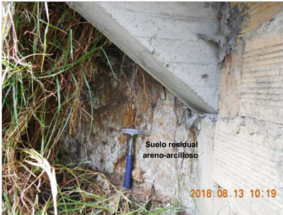
Ilustración 4-48 Afloramiento en taludes de cortes – Trinchera 2. Coordenadas E: 90037m N: 98538m
