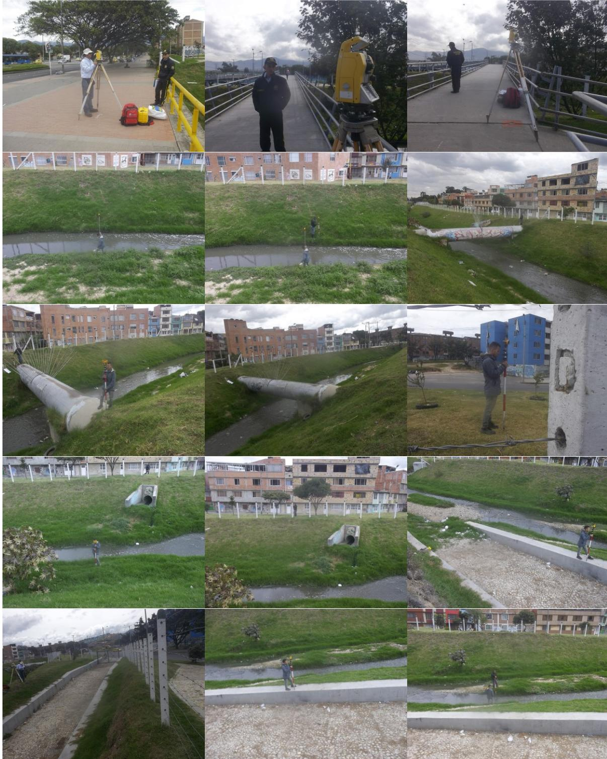
Ilustración 36. Levantamiento de secciones mediante radiación de detalles
