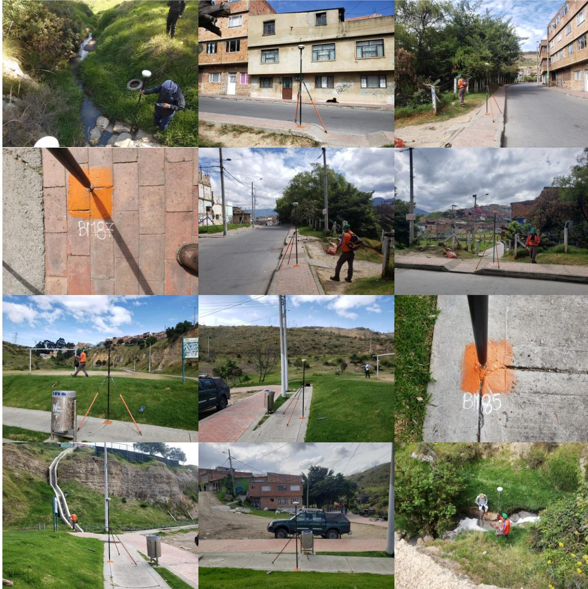
Ilustración 40. Levantamiento de detalles mediante RTK
