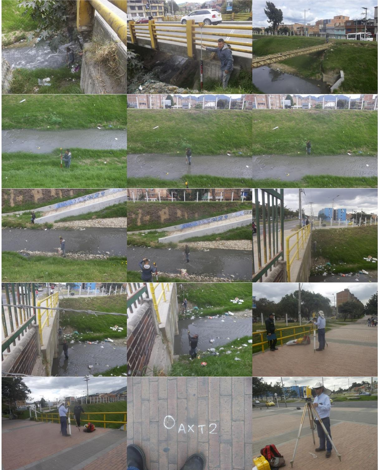
Ilustración 35. Levantamiento de secciones mediante radiación de detalles
