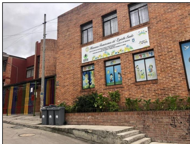
Fotografía 24. Edificaciones en la zona de interés
