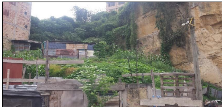
Fotografía 6. Panorámica hacia el talud donde se presentó una emergencia que acusó el desalojo temporal de viviendas
