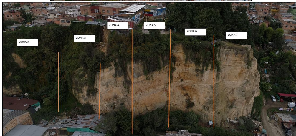
Fotografía 22. Sectores de evaluación del talud área de estudio.
