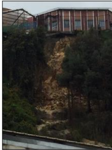
Fotografía 1. Caída de detritos. Hacia la parte alta se ubica el Hogar infantil CDI Estrella de Oriente.
