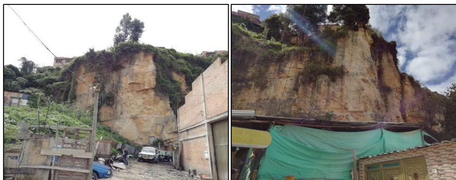
Fotografía 2. Zona norte del talud de estudio (Izquierda) y Zona central del talud de estudio (Derecha)
