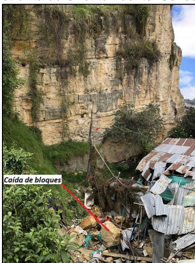
Fotografía 19. Caída de bloques en la pata del talud 3 (parte baja) Fuente: Consorcio Himec – Consulcons, 2018.
