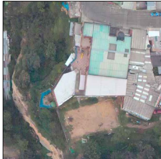
Fotografía 23. Corona del talud
