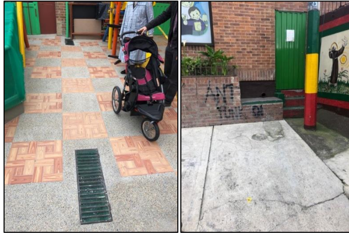
Fotografía 25. Obras de drenaje en la zona de interés
