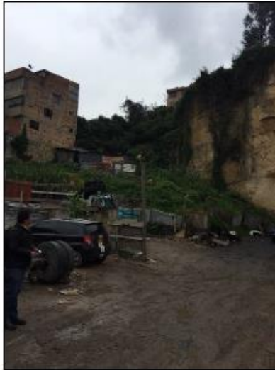
Fotografía 2. Panorámica hacia talud en roca y zona de depósitos en el costado norte del área de estudio.
