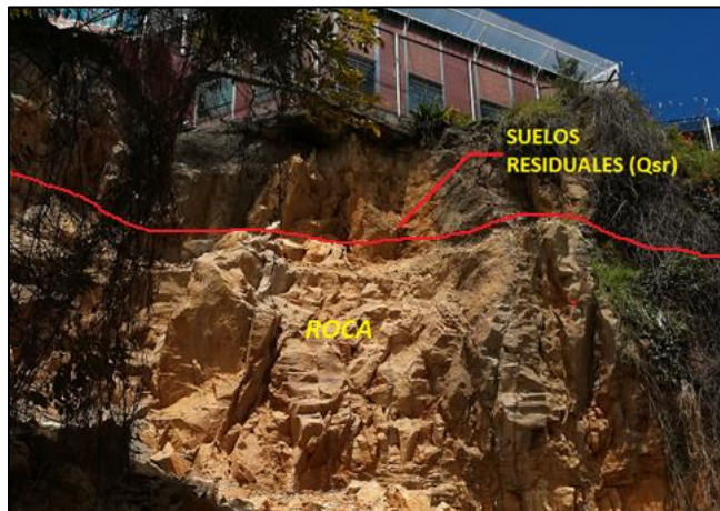
Fotografía 10. Afloramiento de suelos residuales, arenosos y limosos, localizados en el tope del talud rocoso ubicado al costado occidental del CDI Estrellita de Oriente El Codito – Localidad de Usaqué. Fuente: Consorcio Himec – Consulcons, 2018
