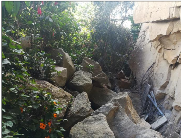
Fotografía 11. Depósito de bloques, con ausencia de matriz, localizado en la base del talud ubicado en la parte central de la zona de interés. Fuente: Consorcio Himec – Consulcons, 2018
