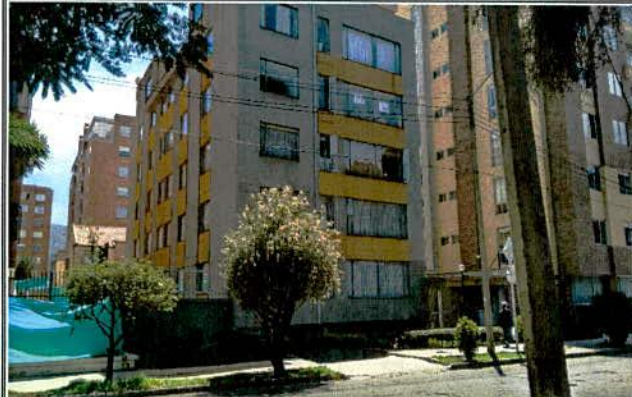
Foto No. 1. Vista frontal de la edificación emplazada en el predio de la Carrera 18 B No. 145 - 28
