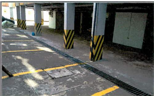
Foto No. 7. Vista general del semisótano - Tomado de DI-10220 - 09/02/2017
