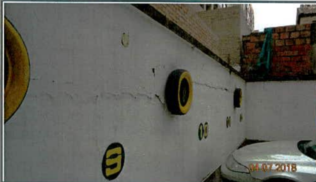
Foto No. 3 y 4. Grietas en muro de cerramiento perimetral sector del semisótano
