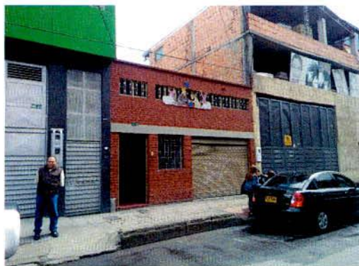
Foto 1. Vista de la vivienda de la Calle 81 # 90 - 29.
