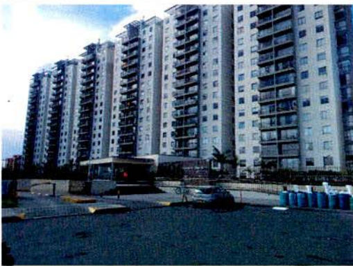
Foto 1. Vista del conjunto residencial de la Carrera 63 # 22 - 45
