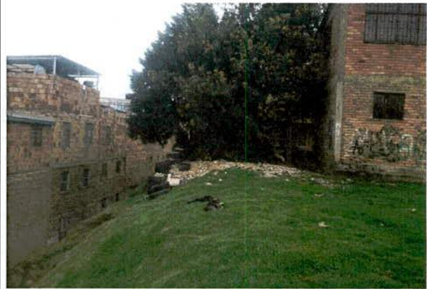
Fotografía 6. Acumulación de escombros ubicada en la parte alta de la ladera inspeccionada a la altura de la Carrera 14 l entre la Calle 73 D Bis Sur y la Calle 74 B Sur.
