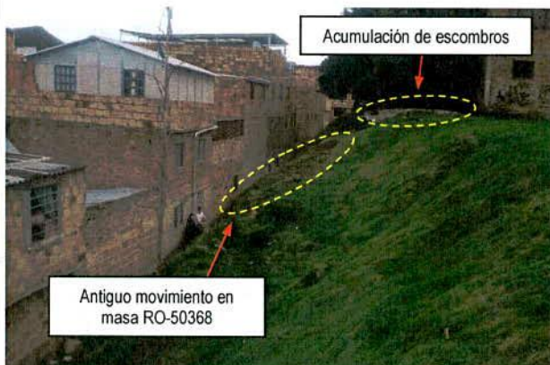
Fotografía 4. Vista de la ladera inspeccionada a la altura de la Carrera 14 l entre la Calle 73 D Bis Sur y la Calle 74 B Sur, se observa el antiguo movimiento en masa y la zona donde se depositan escombros.
