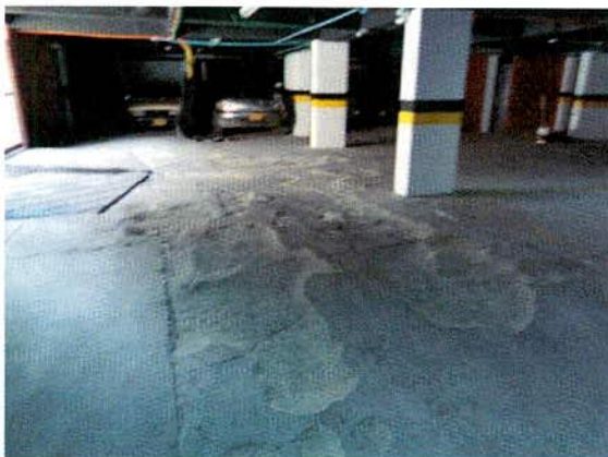
Fotografías 2 y 3. Perdida de material de sobrepiso en los parqueaderos de primer piso y sótano
