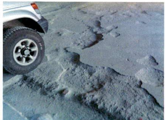
Fotografías 2 y 3. Perdida de material de sobrepiso en los parqueaderos de primer piso y sótano
