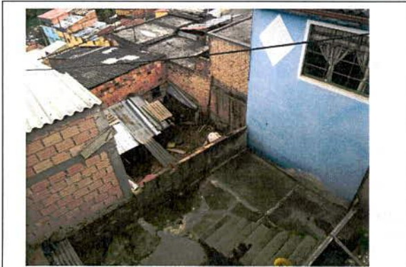
Foto 3. Vista de la vivienda de la Calle 6B No. 3 – 31.
