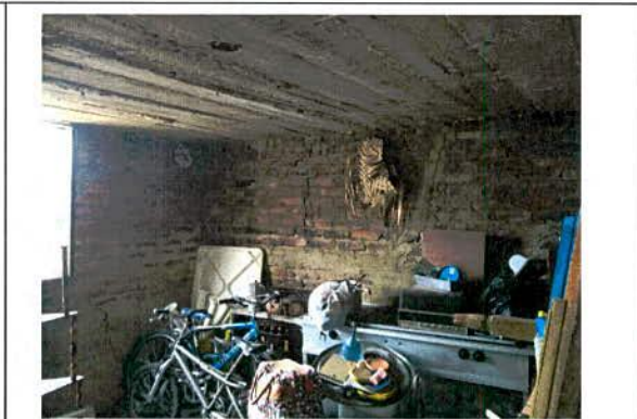
Foto 4. Hall de acceso a los interiores 1, 2 y 3 del predio de la Calle 6B No. 3 – 31
