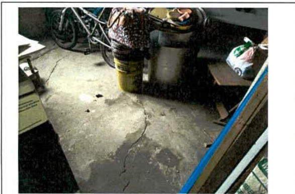
Foto 5. Vista de la vivienda de la Calle 6B No. 3 – 31.
