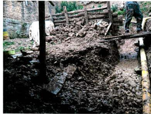
Foto 10. Hall de acceso a los interiores 1, 2 y 3 del predio de la Calle 6B No. 3 - 31
