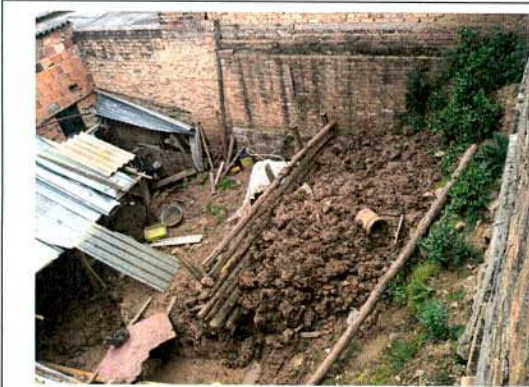
Foto 9. Vista de la vivienda de la Calle 6B No. 3 - 31.
