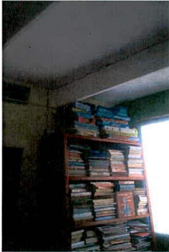
Fotografía 7. Separaciones entre vigertería y losetas de la placa de entrepiso del costado suroriental de la vivienda ubicada en el predio de la Carrera 11 B No. 34 – 51 Sur.
