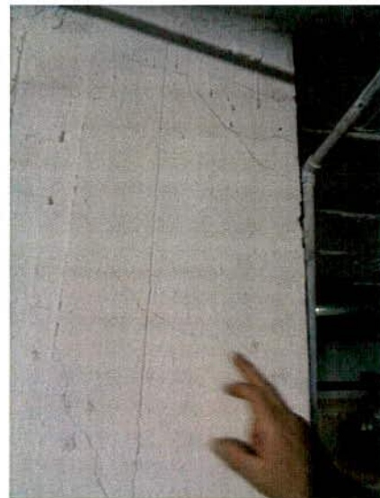
Fotografías 3 y 4. Fisuras en las columnas del sótano de edificio Canoa I.
