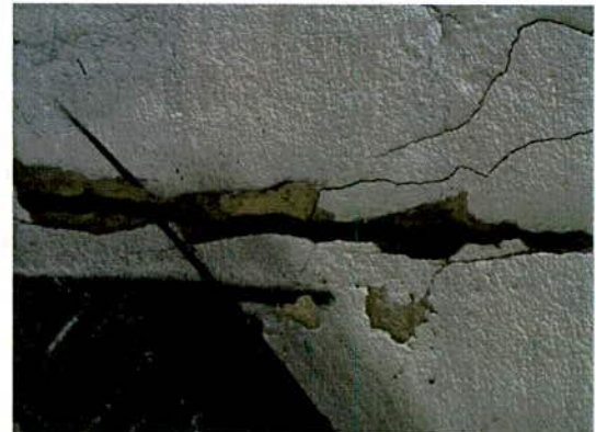
Fotografías 7 y 8. Grieta horizontal en el muro de cerramiento del costado posterior del edificio Canoa I
