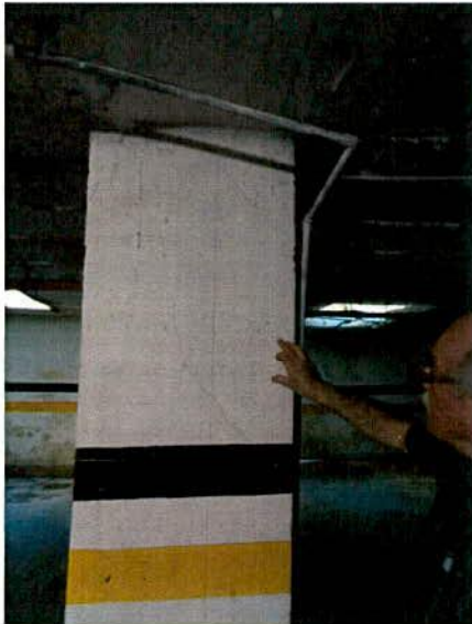
Fotografías 3 y 4. Fisuras en las columnas del sótano de edificio Canoa I.
