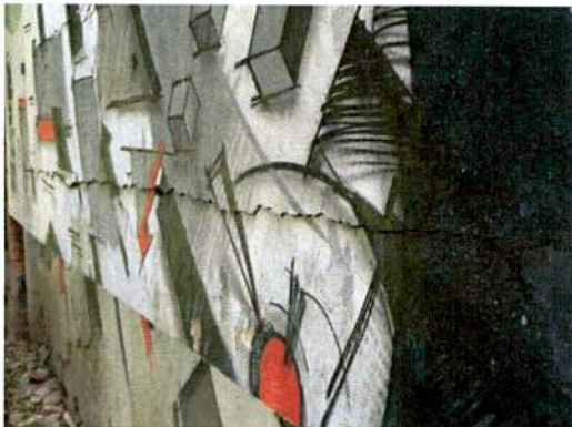
Fotografías 7 y 8. Grieta horizontal en el muro de cerramiento del costado posterior del edificio Canoa I
