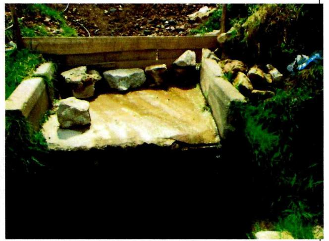
**Fotografía 13.** Caja de inspección del sistema de alcantarillado, en las obras de estabilización de la Carrera 13 Este, límite occidental del plan parcial.
