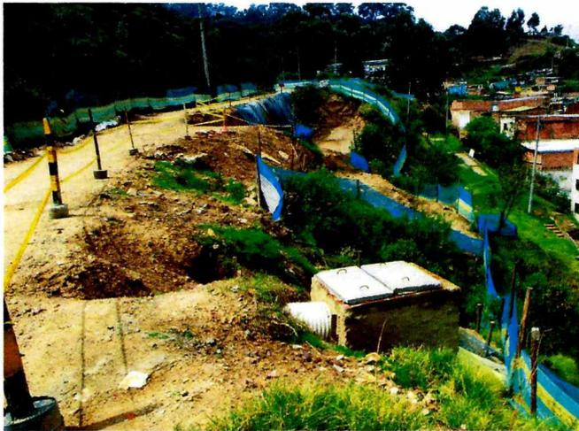
**Fotografía 12.** Caja de recolección de aguas, en las obras de estabilización de la Carrera 13 Este, límite occidental del plan parcial.
