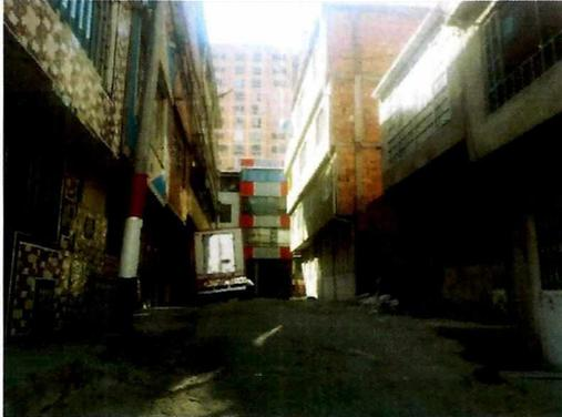
**Fotografía N°3.** Vías internas del desarrollo sin estructura de pavimento ni estructuras de drenaje.
