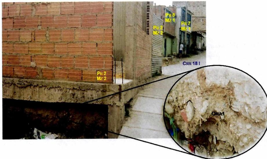
**Foto 4** Acumulación de Restos de Escombros y de Raíces Embebidos en Arcilla-Arenosa o Arena-Arcillosa Dispuesta Para Cimentar el Predio 2 de la Manzana 2
