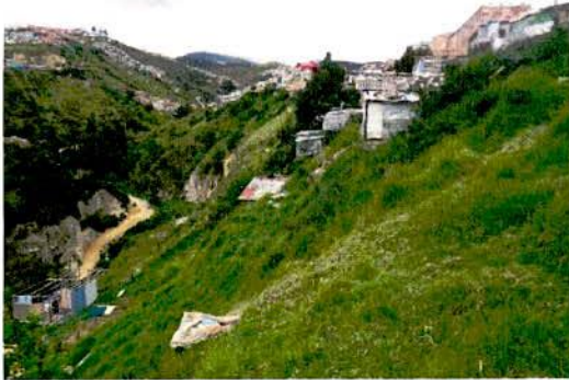
Fotografía 3. Se muestra de norte a sur la pendiente del terreno y las viviendas construidas de manera escalonada a media ladera.
