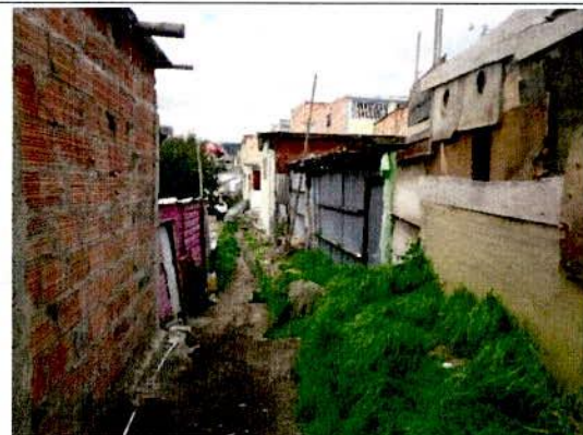
Fotografía 2. Senderos peatonales dentro de sector evaluado sin estructura de pavimento y sin obras de captación de escorrentía superficial.
