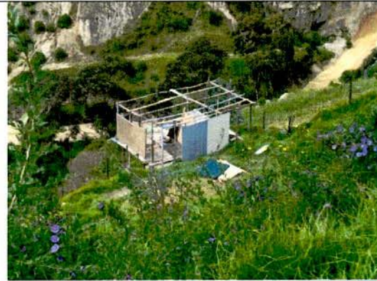
Fotografía 4. Vivienda en construcción en material de recuperación, conformado por madera, láminas de latón y cubierta en tejas de zinc.
