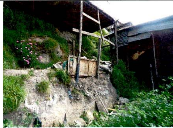
Fotografía 8. Construcciones con sistemas palafíticos apoyados directamente sobre el terreno donde se han realizados cortes.
