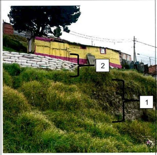
Fotografía 10. Visita 30 Julio de 2018. 2) Nuevos rellenos, como cimentación para implantación de viviendas.
