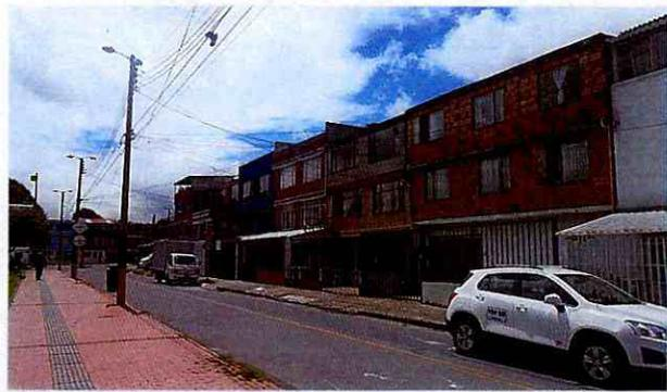
**Fotografía N°3.** Panorámica predios ubicados en la Carrera 89. Edificaciones de 3 y 4 niveles construídos en mampostería confinada y semiconfinada.
