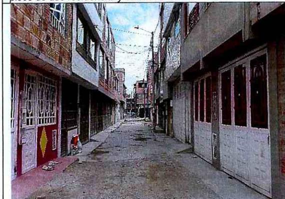
Fotografía 5: Calle 42G Bis sur, se evidencian construcciones bien constituidas de hasta tres pisos. Se encuentra la vía pavimentada en mal estado y con servicios públicos, pero sin evidencia de estructuras hidráulicas para el drenaje.
