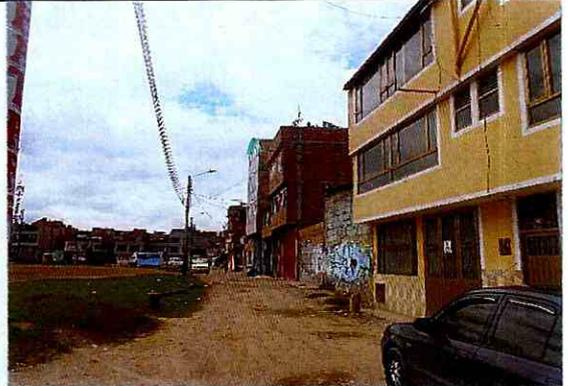
Fotografía 2: Calle 42FBis A sur, donde se evidencia una vía sin estructura de pavimento y sin sumideros. En este sector del desarrollo se evidencian construcciones de hasta cuatro pisos de uso residencial.
