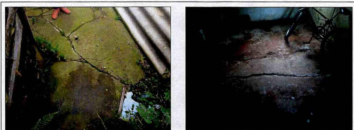
**Fotografías 18 y 19.** Grietas generadas por deficiencias constructivas evidenciadas en las viviendas localizadas en los predios 27 y 28 de la Manzana 4
