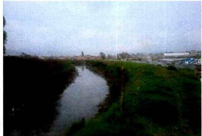
**Fotografía No. 2** Se observan los Jarillones bien conformados, en la parte baja se observa residuos sólidos y sedimentos depositados en el fondo del cauce.
