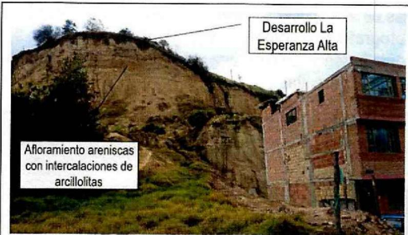
**Fotografía 3.** Vista desde abajo del talud que bordea el desarrollo La Esperanza Alta, caracterizador por un afloramiento de areniscas con intercalaciones de arcillolitas correspondiente a la Formación La Regadera Superior (Ters).
